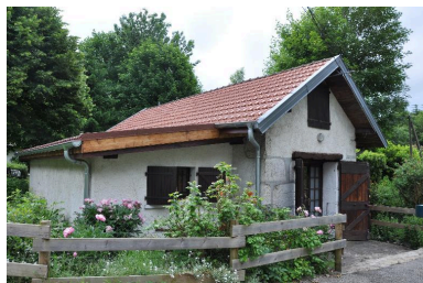
Vue de trois-quart de l'ancien four depuis le nord-ouest Phot. Denys Harreau IVR82_20137300401NUCA
