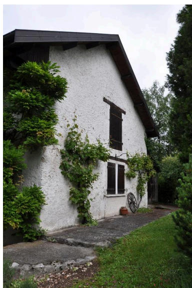
Elévation latérale est de l'ancienne grange Phot. Denys Harreau IVR82_20137300404NUCA
