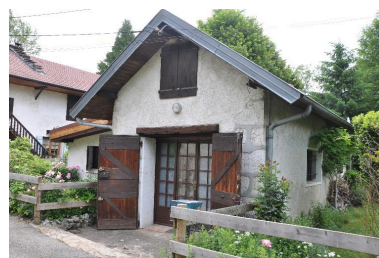
Elevation principale de l'ancien four Phot. Denys Harreau IVR82_20137300405NUCA
