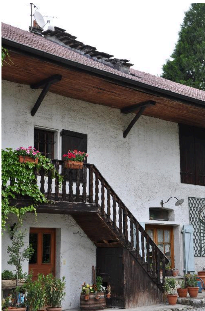
Escalier de distribution extérieur en bois
