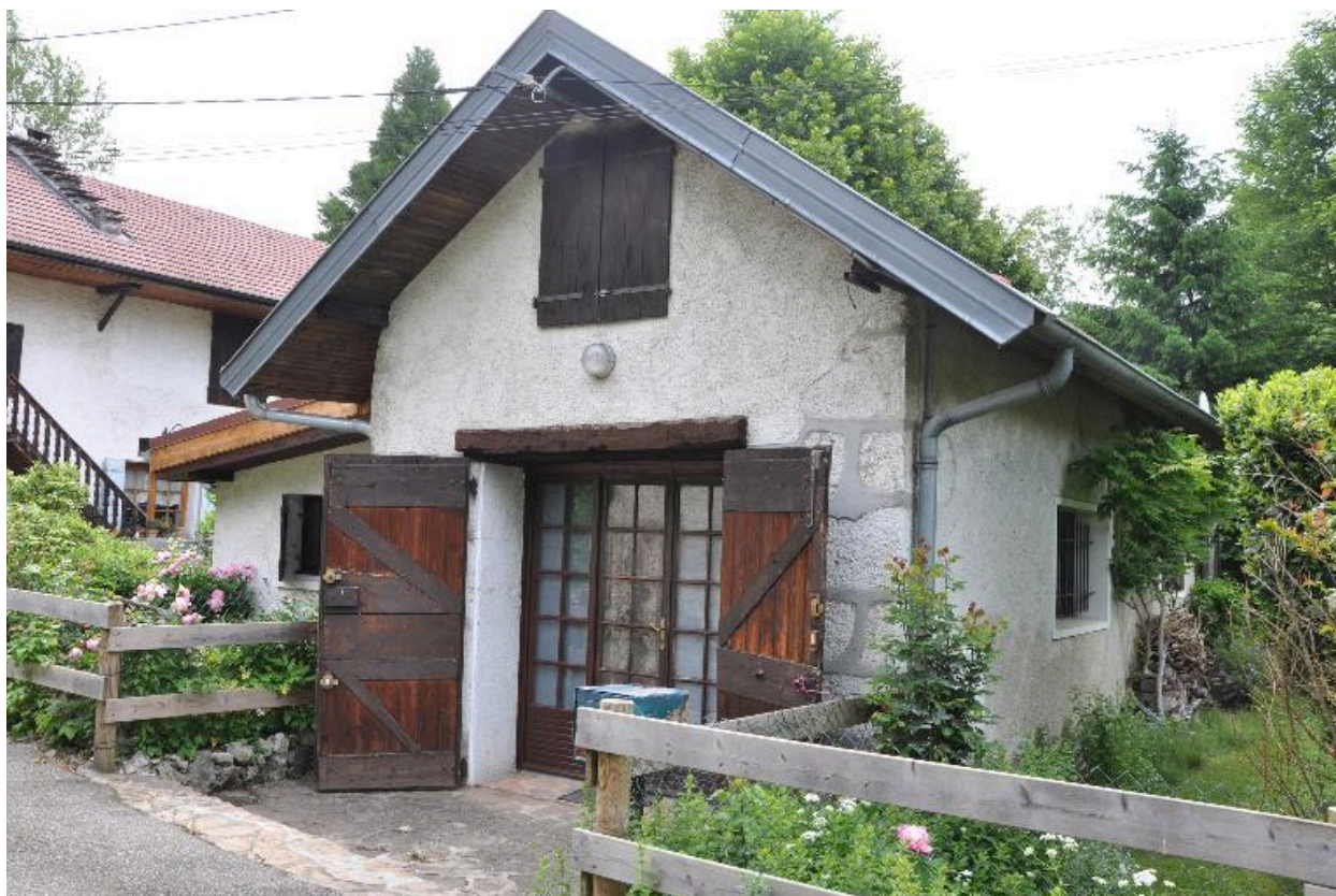
Elevation principale de l'ancien four
