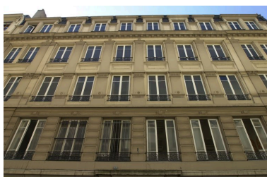
Façade principale, vue par-dessous Phot. Bernard Ducouret IVR82_20046900892NUCA
