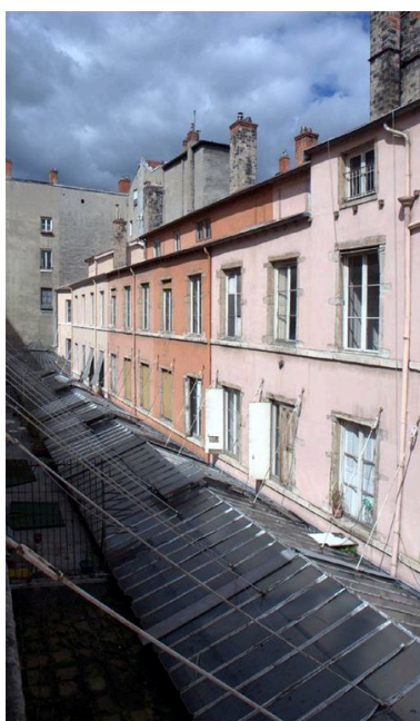
Vue partielle extérieure des immeubles de la partie nord du passage, depuis l'est Phot. Catherine Guégan IVR82_20096900535NUCA
