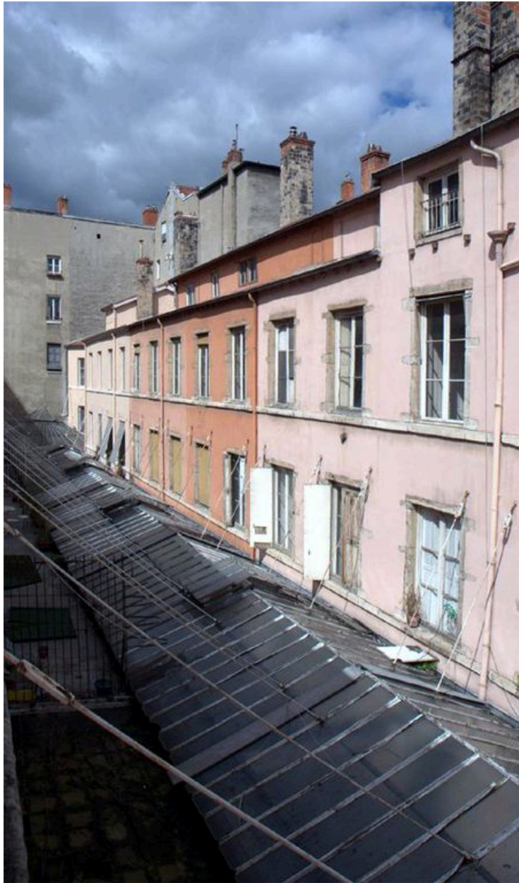
Vue partielle extérieure des immeubles de la partie nord du passage, depuis l'est
