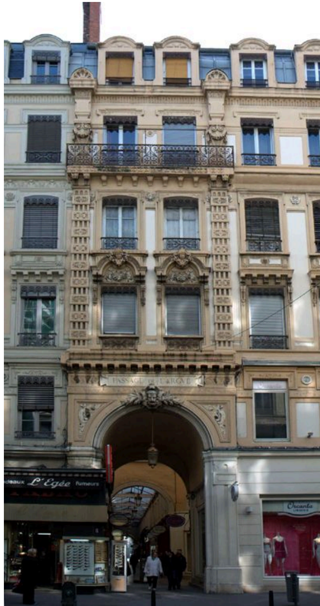
Entrée du passage rue du Président Edouard-Herriot, vue d'ensemble
