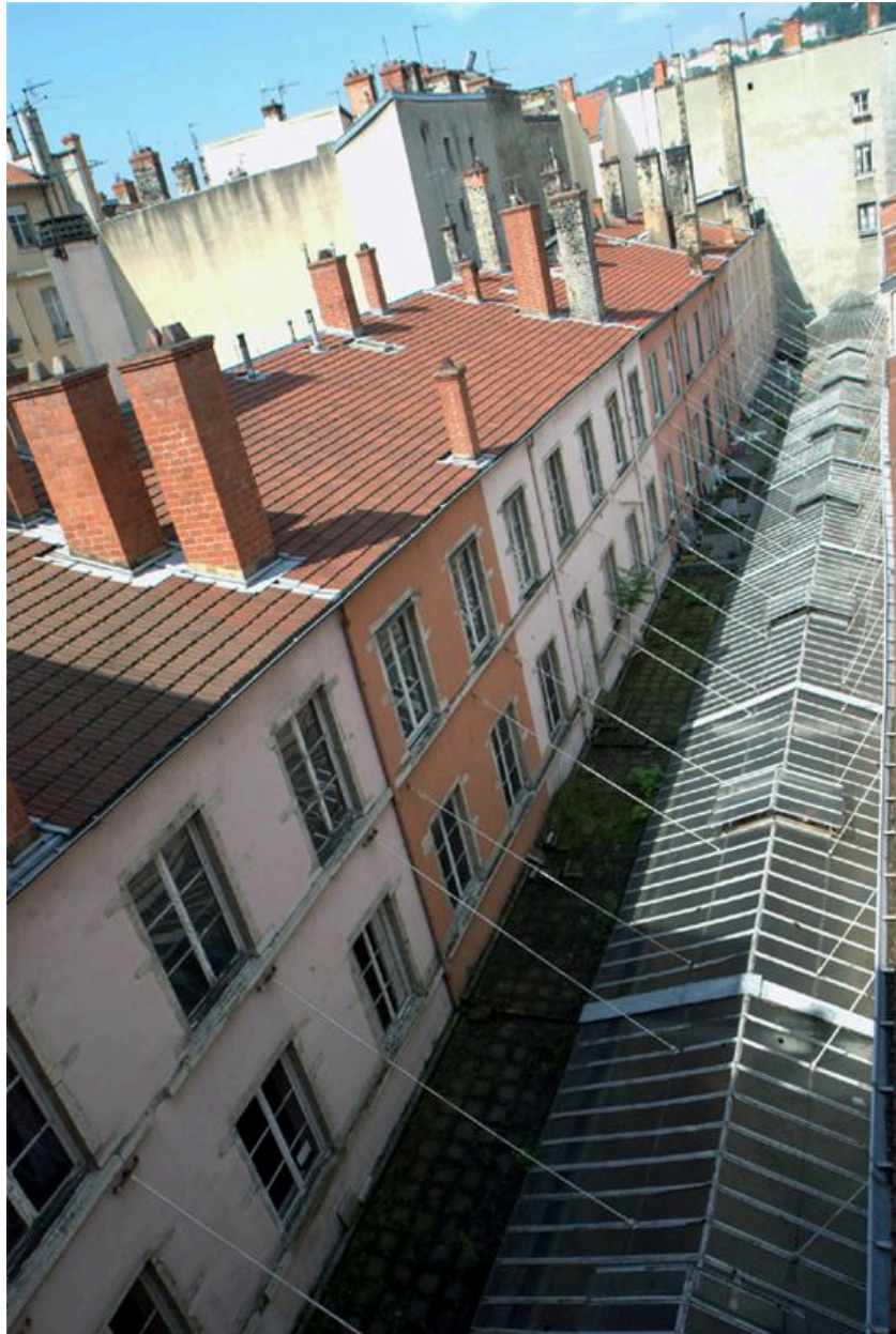
Vue extérieure des immeubles, partie sud du passage, depuis l'est
