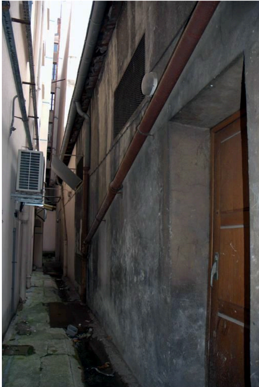
Vue de la cour commune aux immeubles du côté sud du passage, depuis l'ouest
