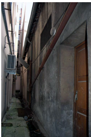
Vue de la cour commune aux immeubles du côté sud du passage, depuis l'ouest Phot. Catherine Guégan IVR82_20096900874NUCA
