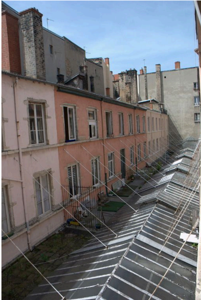
Vue partielle extérieure des immeubles de la partie sud du passage, depuis l'ouest
