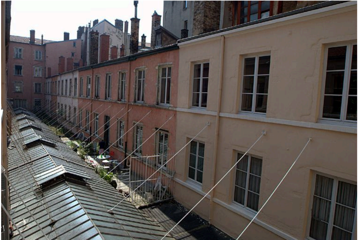
Vue partielle extérieure des immeubles de la partie sud du passage, depuis l'ouest
