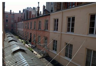
Vue partielle extérieure des immeubles de la partie sud du passage, depuis l'ouest Phot. Catherine Guégan IVR82_20096900880NUCA
