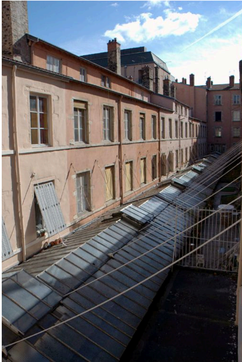
Vue partielle extérieure des immeubles de la partie nord du passage, depuis l'ouest
