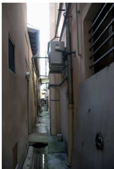
Vue de la cour commune aux immeubles du côté sud du passage, depuis l'est Phot. Catherine Guégan IVR82_20096900875NUCA
