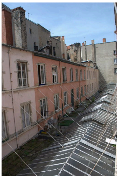
Vue partielle extérieure des immeubles de la partie sud du passage, depuis l'ouest Phot. Catherine Guégan IVR82_20096900662NUCA
