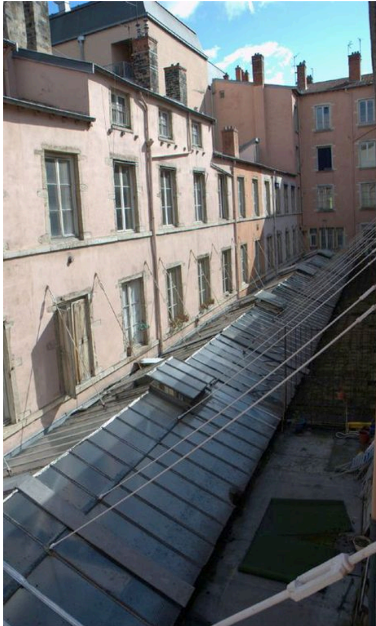
Vue partielle extérieure des immeubles de la partie nord du passage, depuis le sud-ouest
