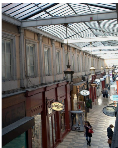
Vue d'ensemble de l'entresol des immeubles du côté sud du passage Phot. Catherine Guégan IVR82_20096900574NUCA
