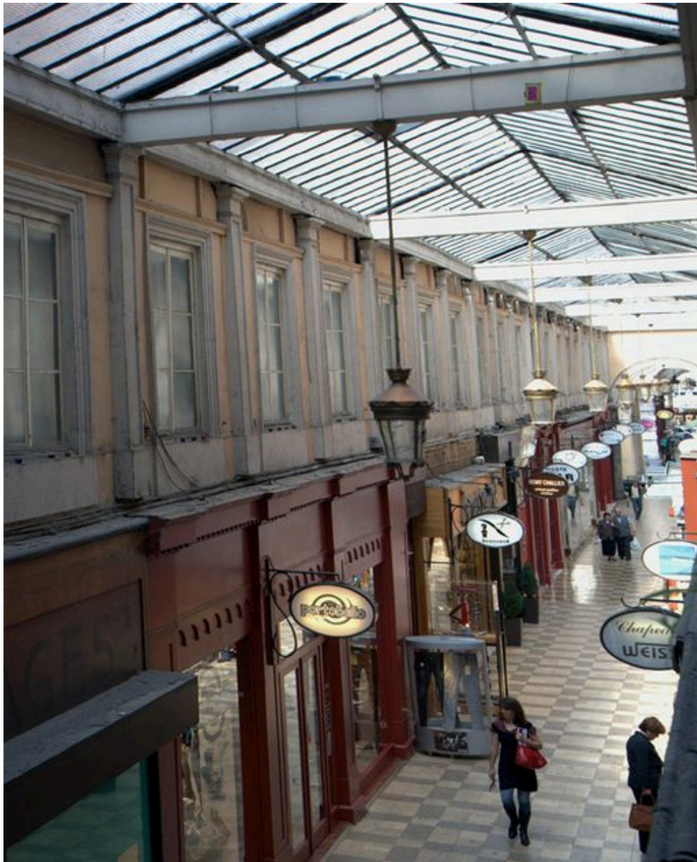
Vue d'ensemble de l'entresol des immeubles du côté sud du passage
