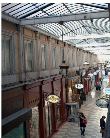
Vue d'ensemble de l'entresol des immeubles du côté sud du passage Phot. Catherine Guégan IVR82_20096900574NUCA
