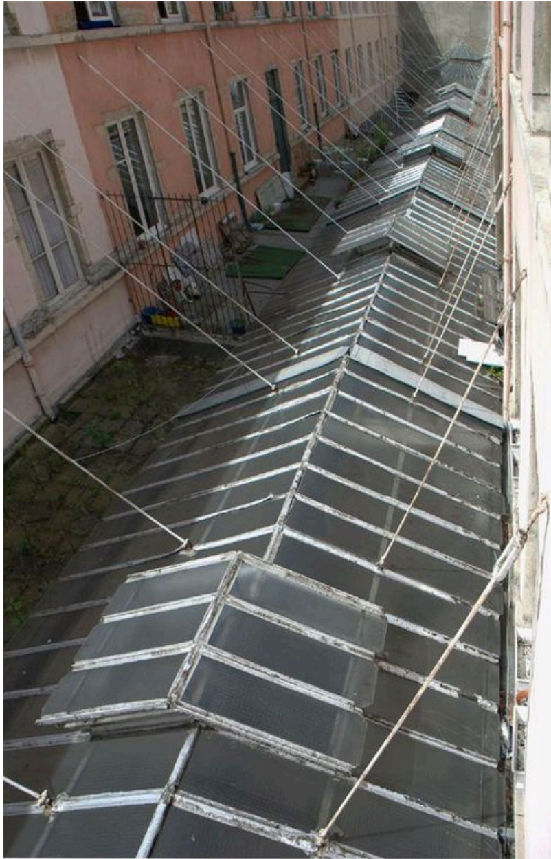
Vue extérieure de la verrière, depuis l'est
