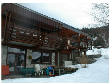
Vue d'ensemble, le chalet Quey à l'extrême droite Phot. Jean-François Lyon- Caen, Phot. C. Salomon-Pelen IVR82_20087302223NUCA
