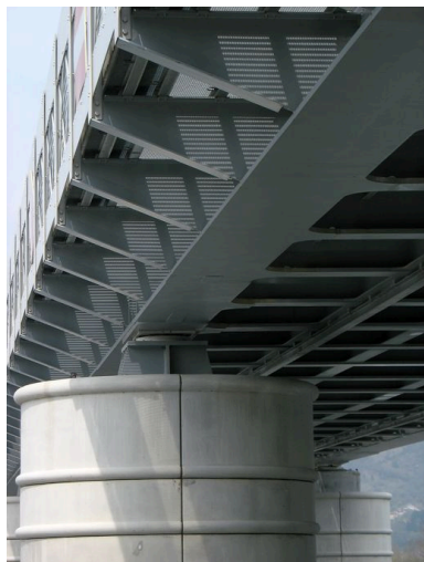
Vue partielle : dessous du tablier et pile Phot. I. Havard IVR82_20090100024NUCA
