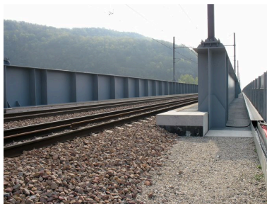
Vue sur le tablier : voie ferrée Phot. I. Havard IVR82_20090100025NUCA
