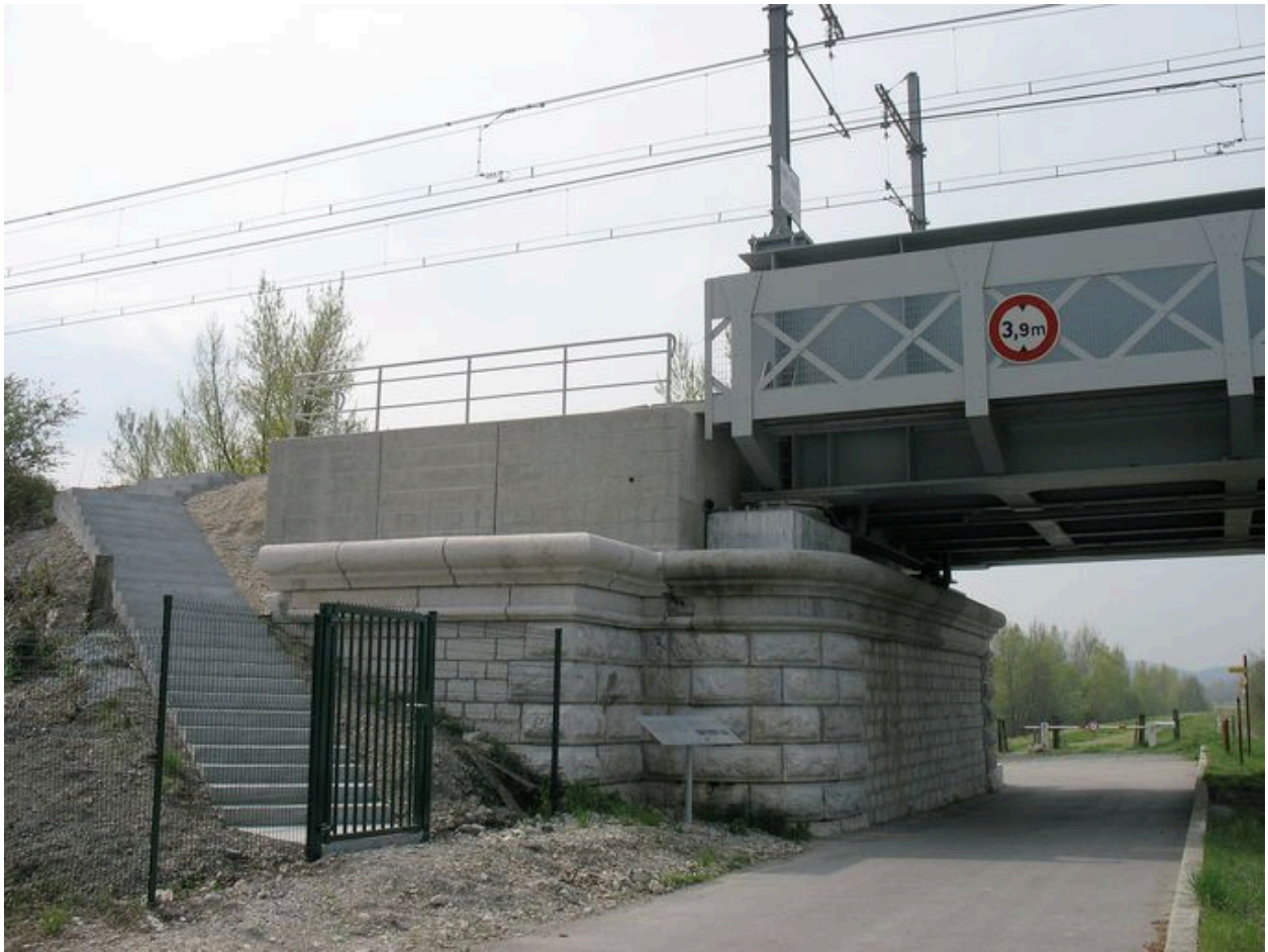
Vue de la culée rive gauche
