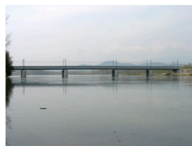
Vue générale du viaduc dans le site, face amont Phot. I. Havard
