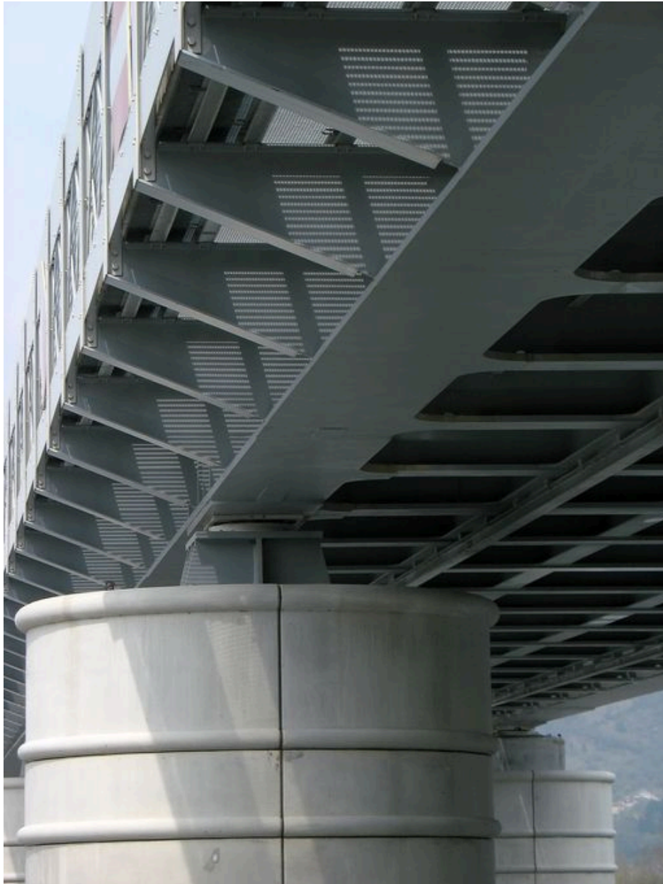
Vue partielle : dessous du tablier et pile
