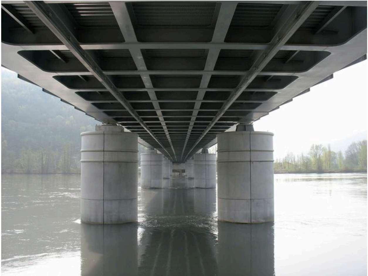
Vue du dessous du tablier
