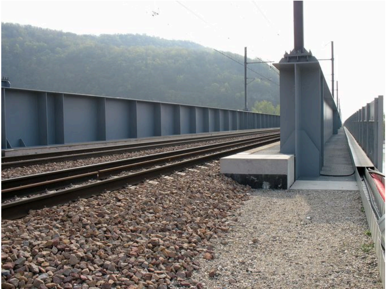
Vue sur le tablier : voie ferrée
