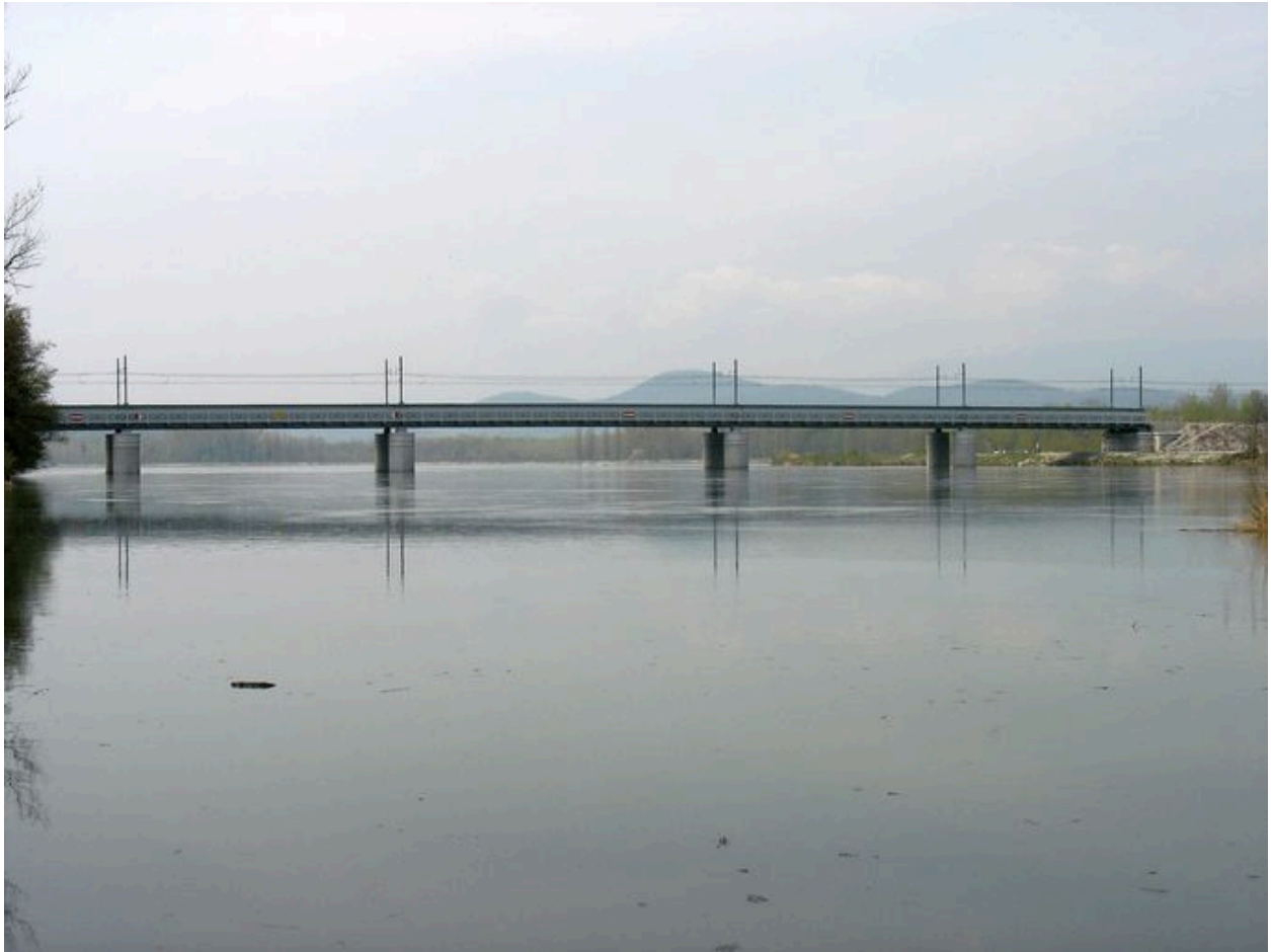
Vue générale du viaduc dans le site, face amont
