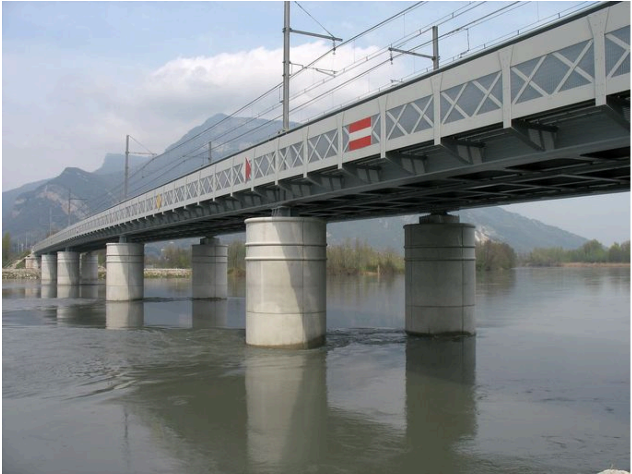
Vue de la face aval (depuis la rive gauche)
