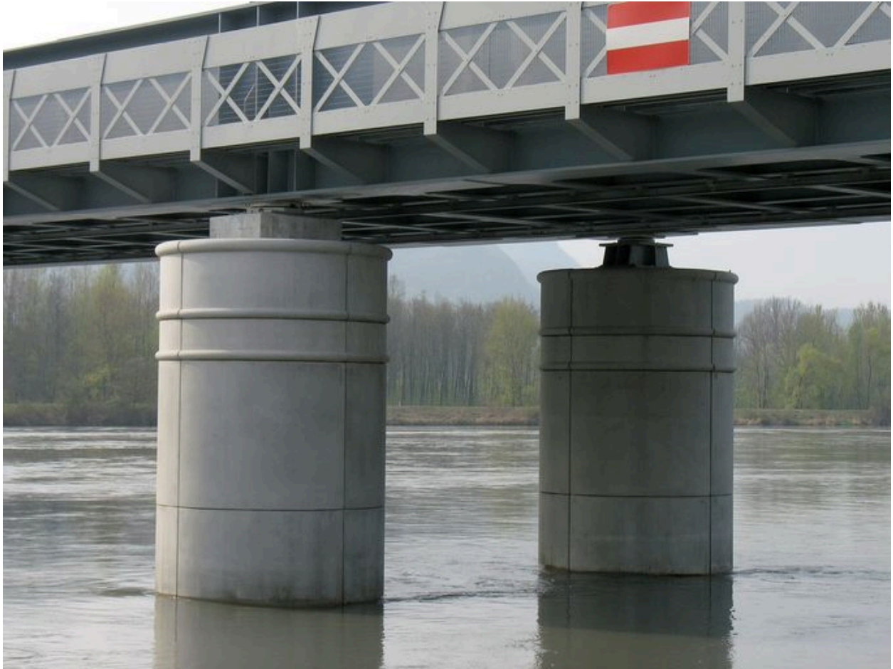
Vue partielle : paire de piles
