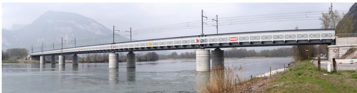
Vue panoramique, face aval (depuis la rive gauche)
