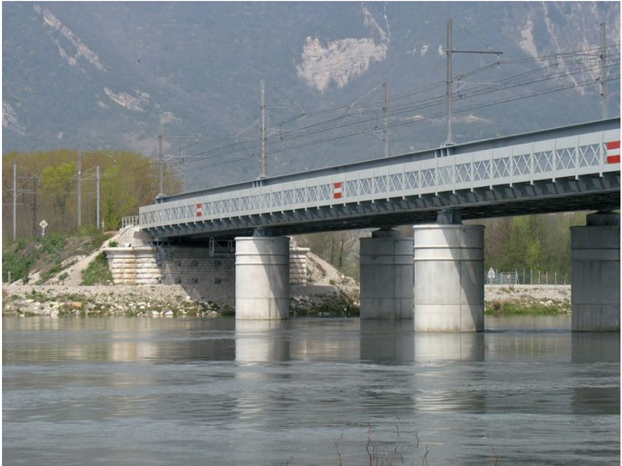
Face aval, vue partielle, rive droite
