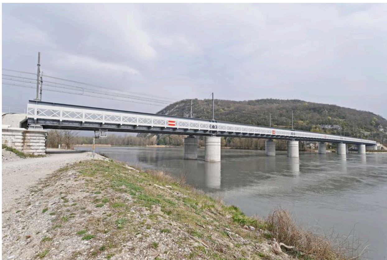
Vue panoramique, face aval (depuis la rive droite)
