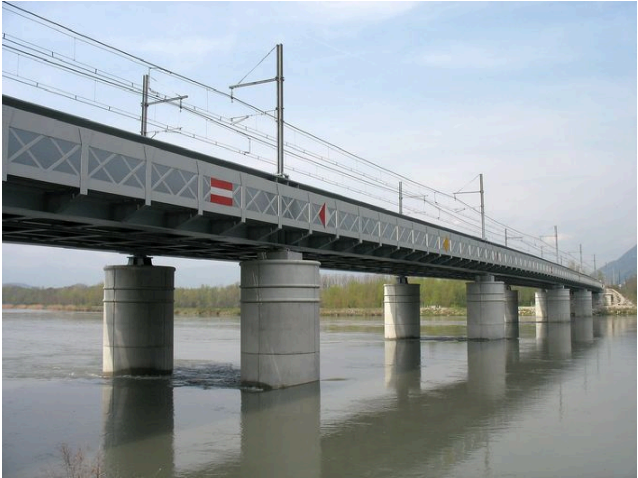
Vue de la face amont (depuis la rive gauche)
