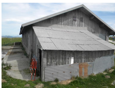
Vue du pignon nord-est de l'étable. Phot. Thierry Monnet IVR82_20157402263NUCA
