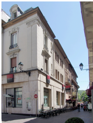
Façade sur rue Phot. François Fouger IVR82_20067300389NUCA
