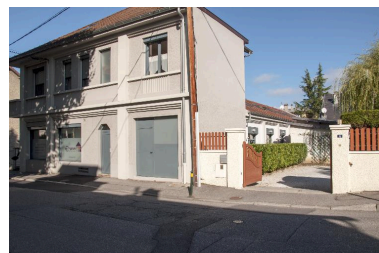
Façade sur rue et élévation postérieure Phot. Denys Harreau IVR84_20177300213NUCA
