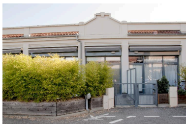
Couronnement pyramidé de la travée centrale Phot. Denys Harreau IVR84_20177300212NUCA
