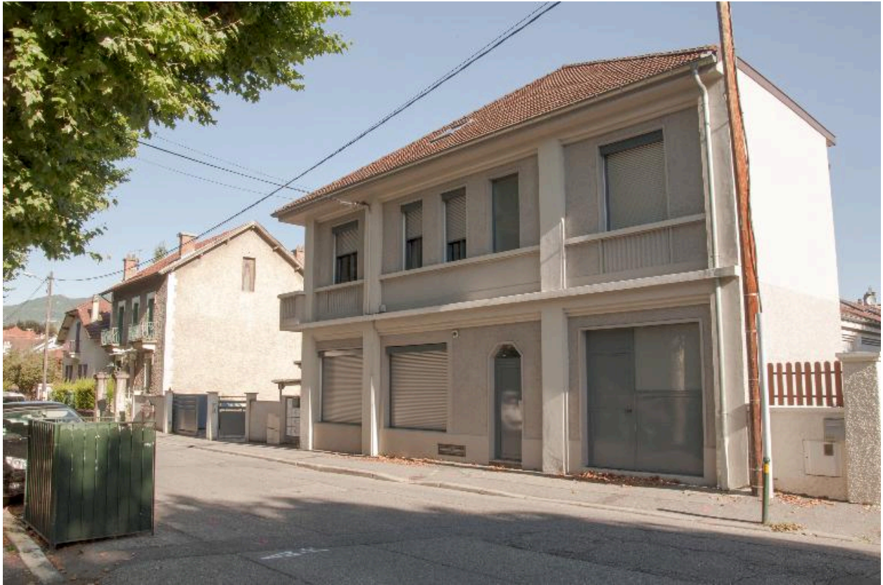
Corps de bâtiment sur rue (ancienne habitation)
