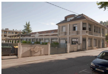
Vue d'ensemble Phot. Denys Harreau IVR84_20177300209NUCA
