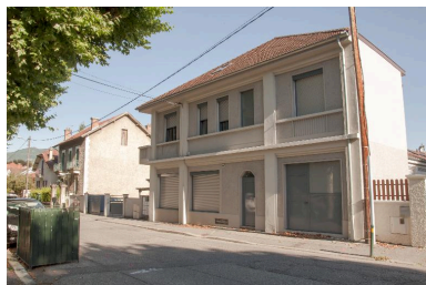
Corps de bâtiment sur rue (ancienne habitation) Phot. Denys Harreau IVR84_20177300208NUCA
