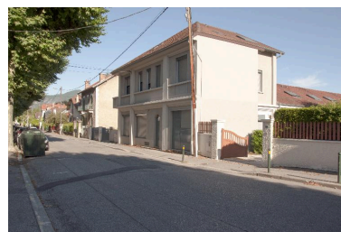
Vue d'ensemble (arrière des bâtiments) Phot. Denys Harreau IVR84_20177300207NUCA
