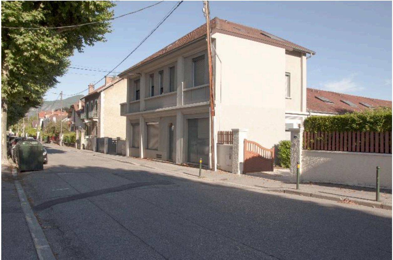
Vue d'ensemble (arrière des bâtiments)
