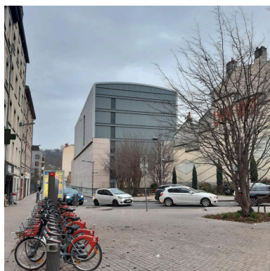
Vue d'ensemble du transformateur EDF Roquette de Vaise Phot. Nadine Halitim-Dubois IVR84_20236900654NUCA
