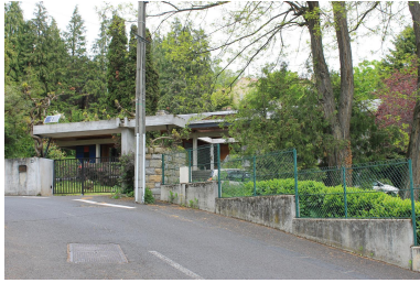
Chamalières, la Maison B. vue depuis la rue de Bellevue. Phot. Christophe Laurent IVR84_20216302423NUCA
