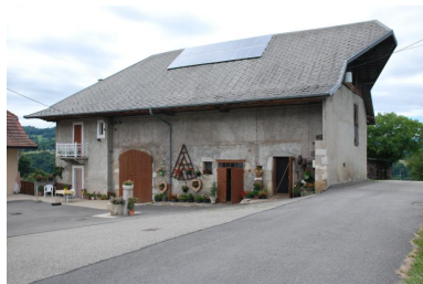
Vue d'ensemble du bâtiment principal. Phot. Caroline Guibaud IVR84_20207402551NUCA
