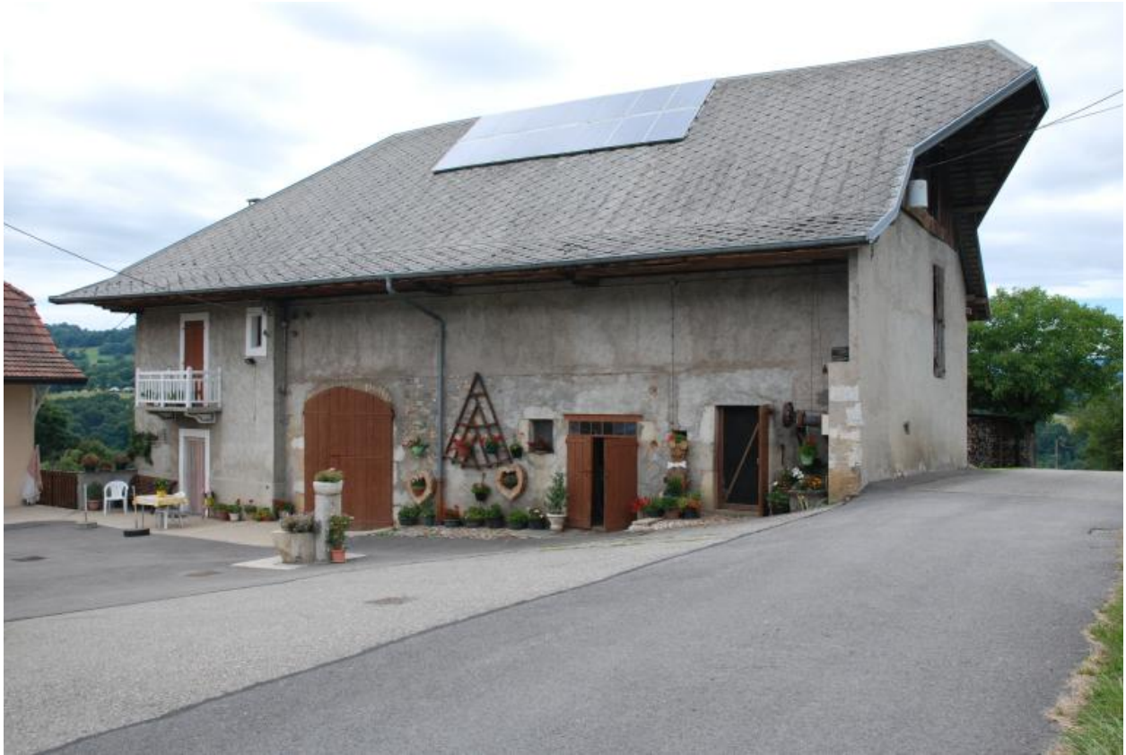
Vue d'ensemble du bâtiment principal.
