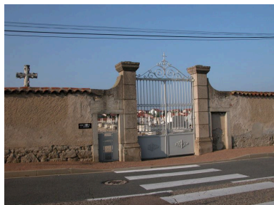
Vue d'ensemble des entrées de la partie ancienne du cimetière. Phot. Thierry Monnet IVR82_20134203101NUCA
