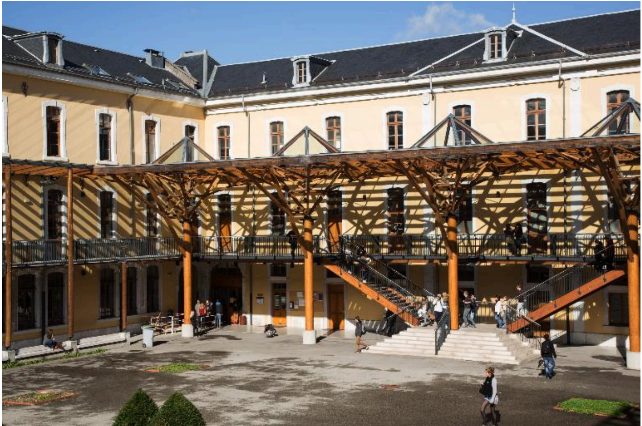
Galerie sous coursières : vue vers le côté nord.
