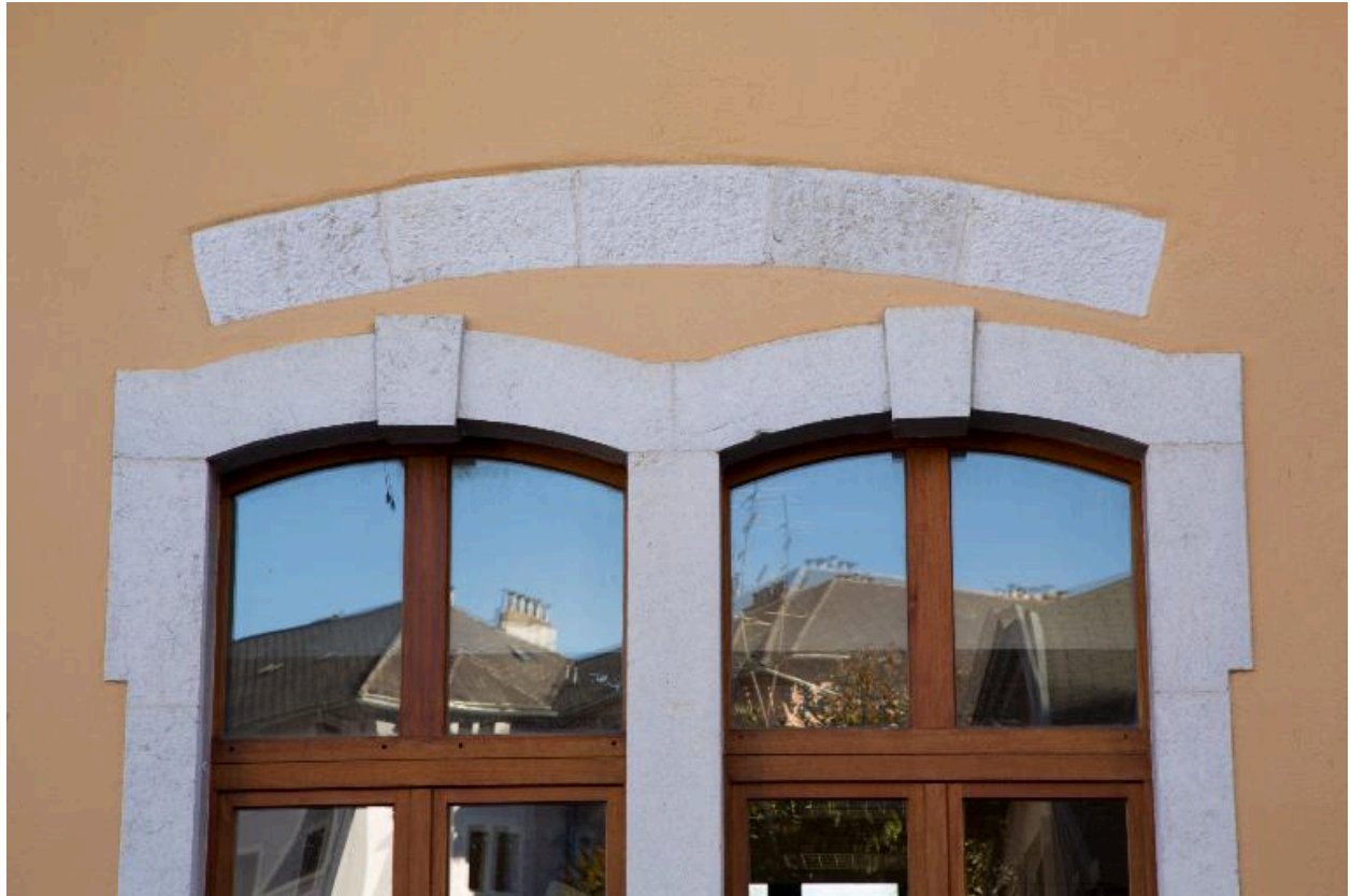
Détail des fenêtres géminées sous arc de décharge.
