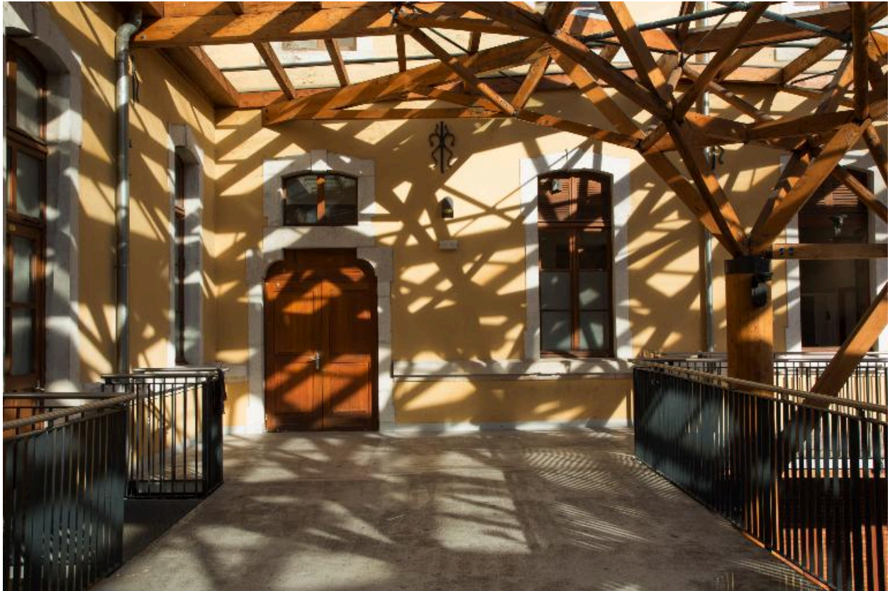
Galerie sous coursières : Protection du passage vers bâtiment 19e à R+1.
