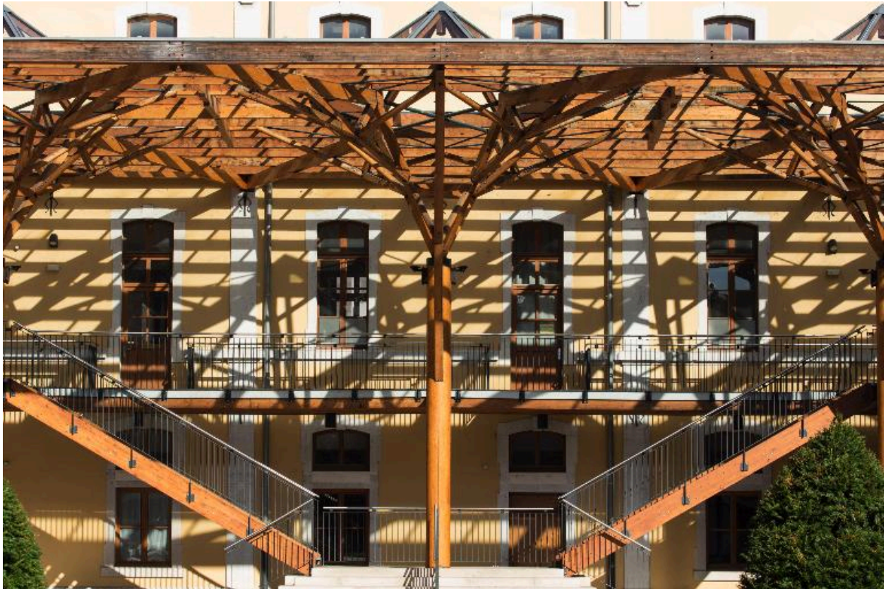
Galerie sous coursières : vue d'ensemble rapprochée.
