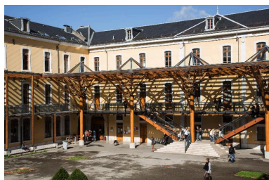
Galerie sous coursières : vue vers le côté nord. Phot. Pascal Lemaître IVR82_20147401667NUCA
