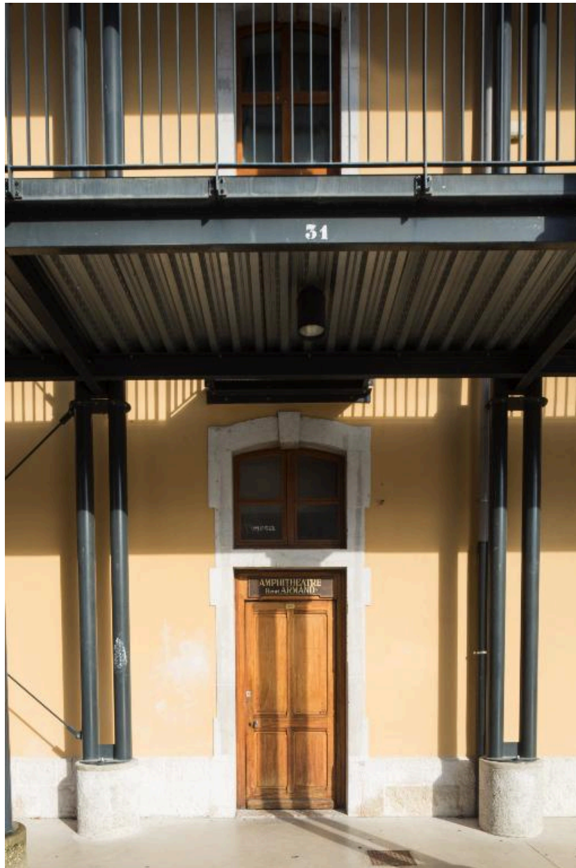
Cour 3, façade sous coursive de la galerie.
