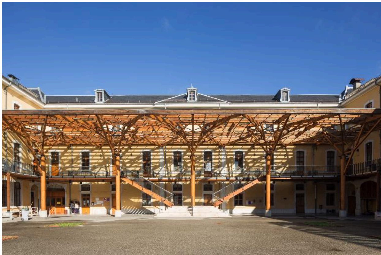
Galerie sous coursières : vue d'ensemble.
