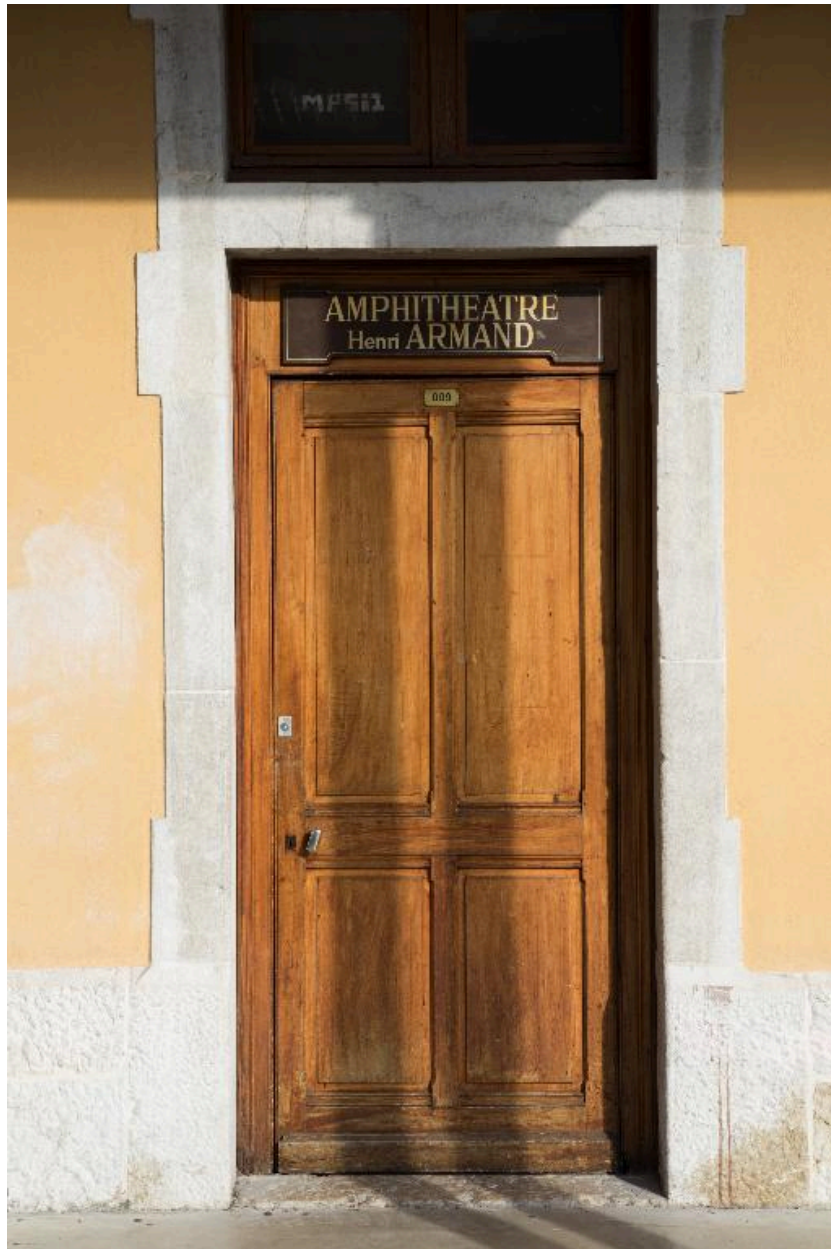
Cour 3, accès en rez-de-chaussée.
