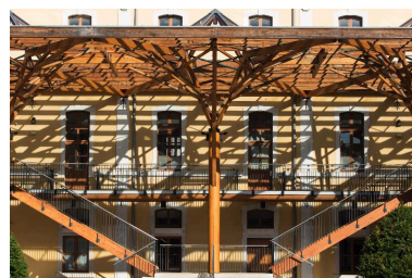
Galerie sous coursières : vue d'ensemble rapprochée. Phot. Pascal Lemaître IVR82_20147401669NUCA
