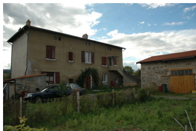
Vue générale du logis Phot. Thierry Monnet IVR82_20134200406NUCA
