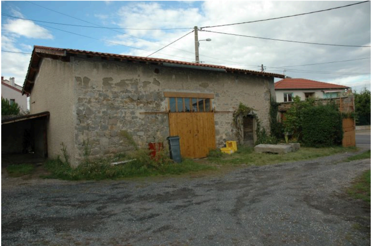
Vue d'ensemble du corps de bâtiment renfermant un cuvage et une cave avec puits.
