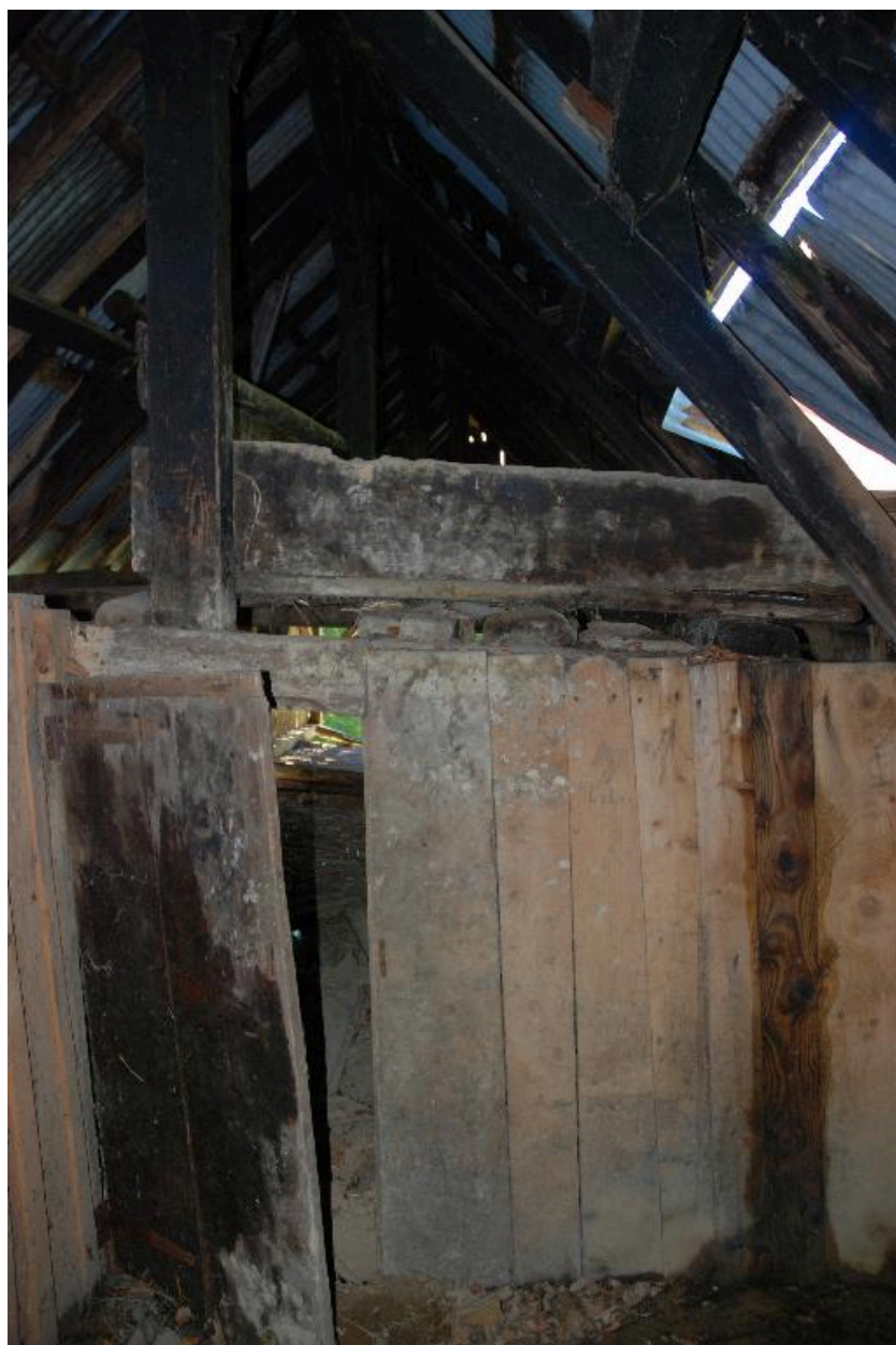
Entrée intérieure de la partie habitation, vers l'étable. Au-dessus de la porte dans le fenil, un bois de lit.
