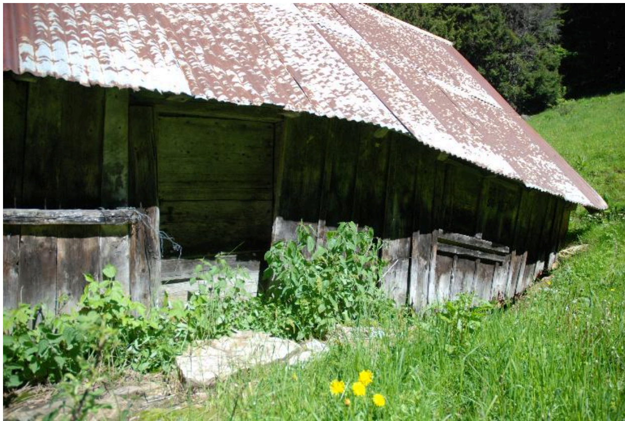
Entrée de l'étable et fenêtre de la pièce de vie.
