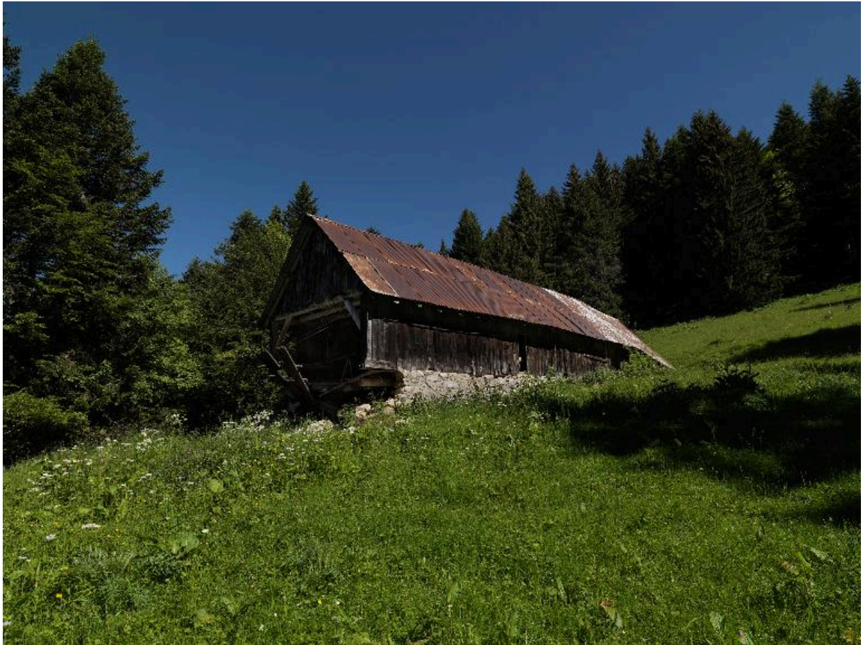
Vue générale depuis le sud-est.
