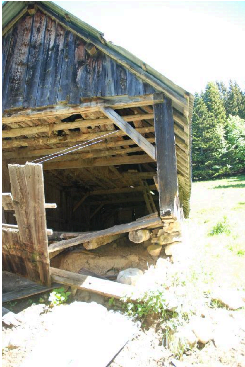
Vue du mur pignon sud de l'étable.
