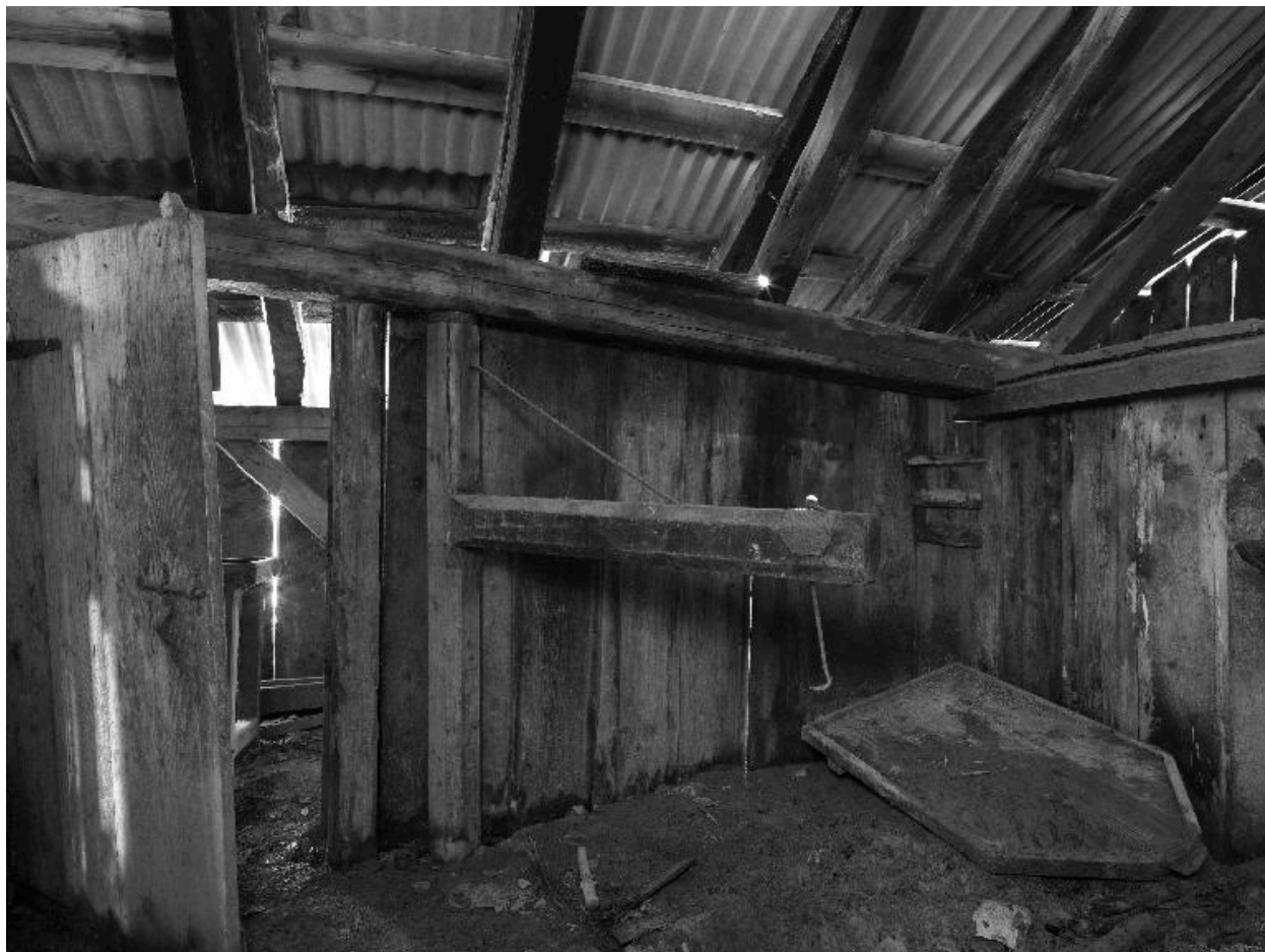
Vue intérieure de la salle de fabrication ; à gauche, entrée du freidi.
