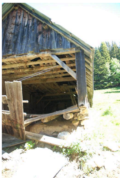
Vue du mur pignon sud de l'étable.
