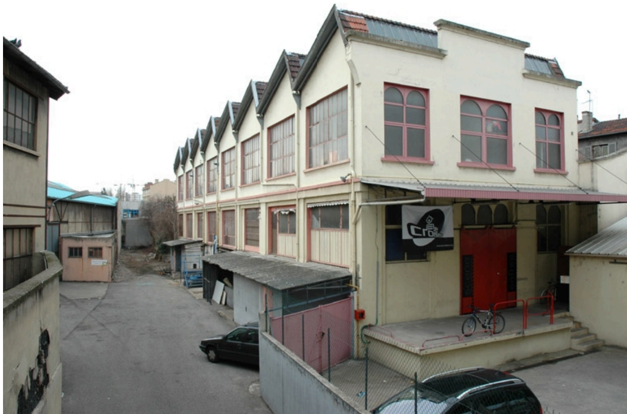
Vue générale nord
