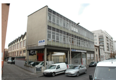
Vue d'ensemble de la rue Croix-Barret Phot. Didier Gourbin IVR82_20056902971NUCA
