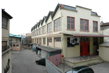
Vue générale nord Phot. Didier Gourbin IVR82_20056902970NUCA
