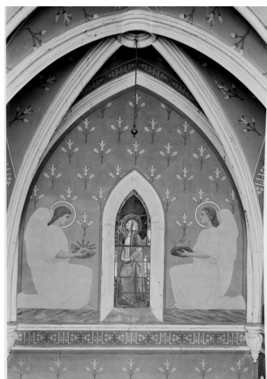
Chapelle de la Vierge : mur nord. Phot. Eric Dessert, Phot. Jean-Marie Refflé IVR82_19910100872P
