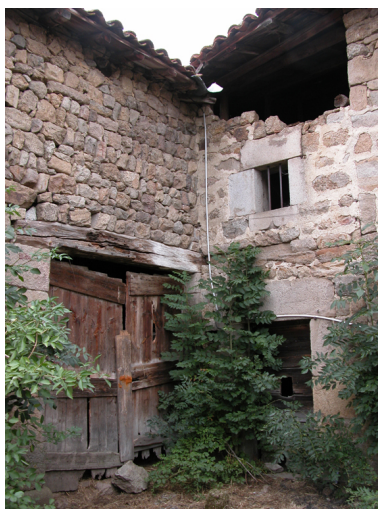
Vue du raccord entre le logis et la grange-étable nord-ouest, depuis la cour. Phot. Caroline Guibaud IVR82_20124200446NUCA
