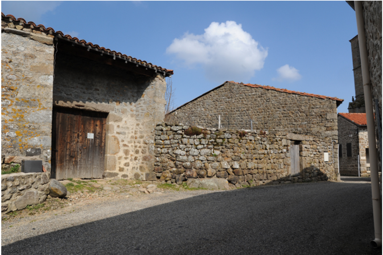
Vue des accès à la cour : passage couvert (et cuvage), porte piétonne dans le mur de clôture.
