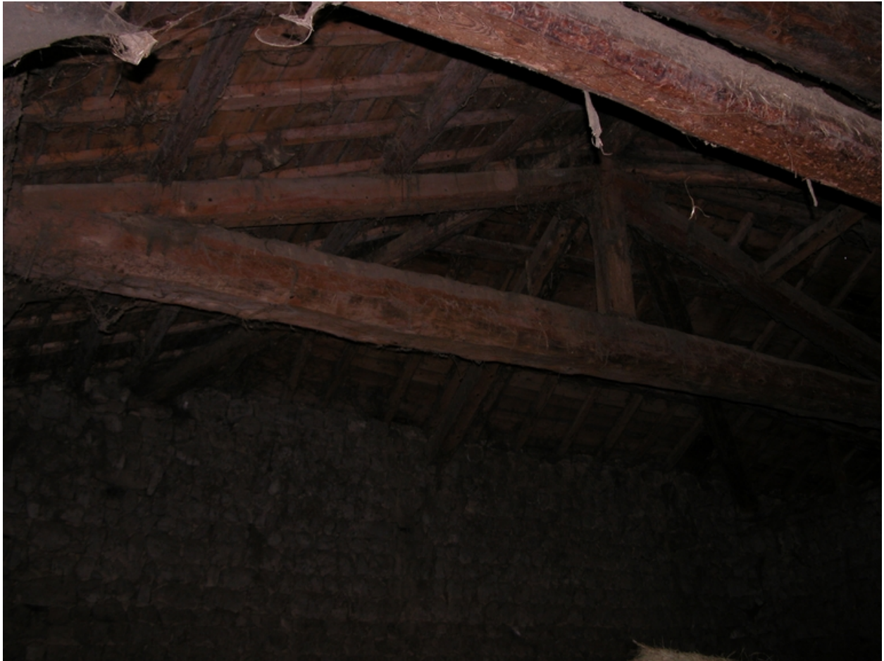
Charpente du passage couvert-cuvage.
