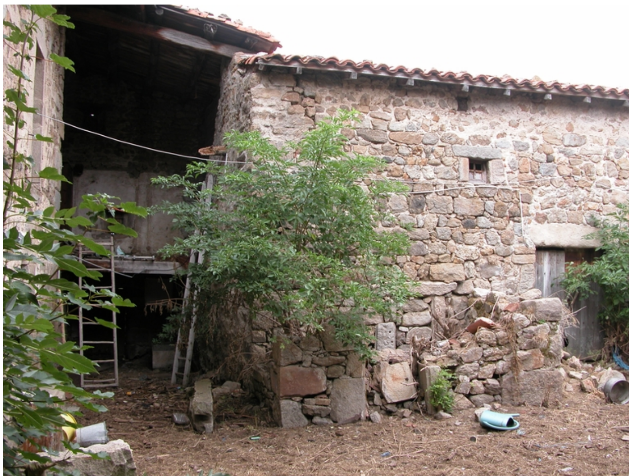
Vue du second passage couvert (angle est), depuis la cour.
