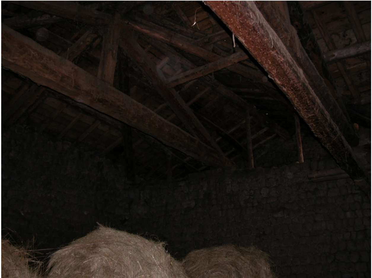
Charpente du passage couvert-cuvage.
