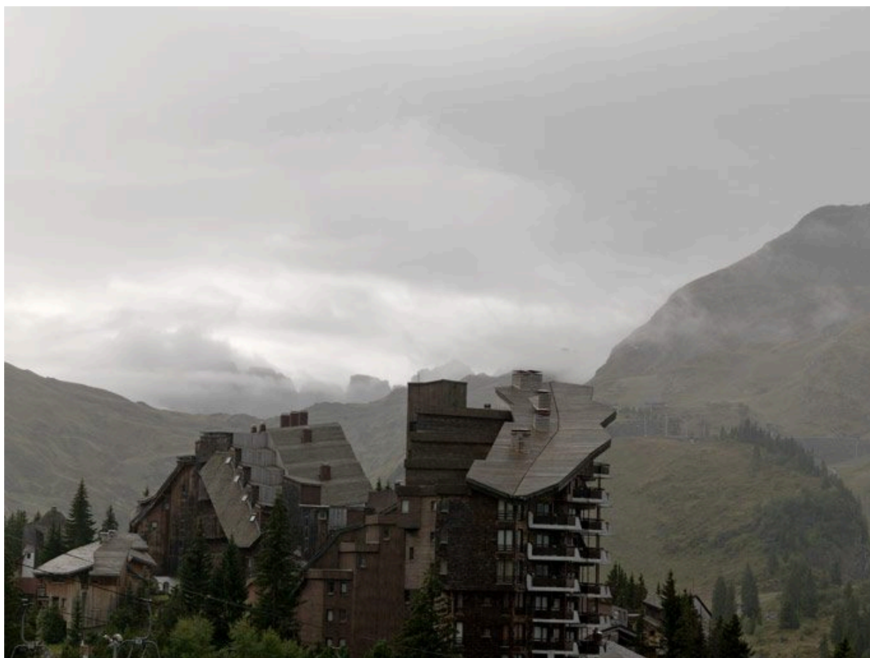
Vue depuis le sud
