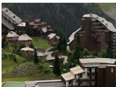
Le nord du quartier. Les chalets au pied du Sassafra Phot. Eric Dessert IVR82_20097400638NUCA
