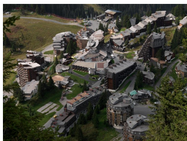
Partie sud-ouest Phot. Eric Dessert IVR82_20097400624NUCA
