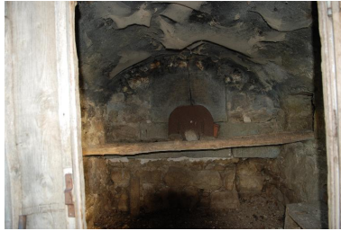
Vue intérieure du four à pain. Phot. Thierry Monnet IVR84_20177301874NUCA
