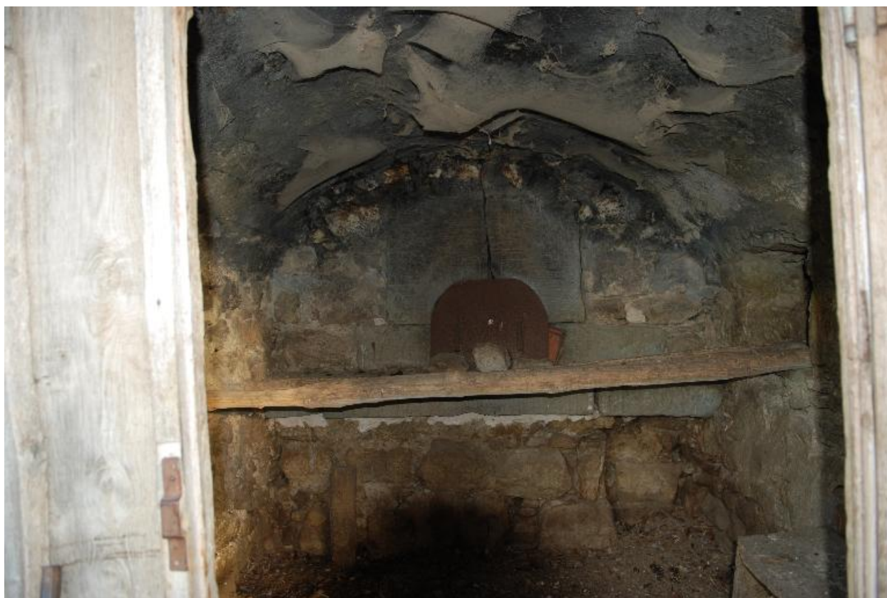
Vue intérieure du four à pain.
