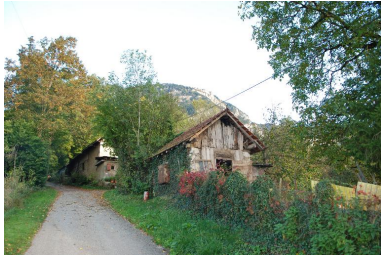
Vue d'ensemble du four à pain Phot. Thierry Monnet IVR84_20177301873NUCA
