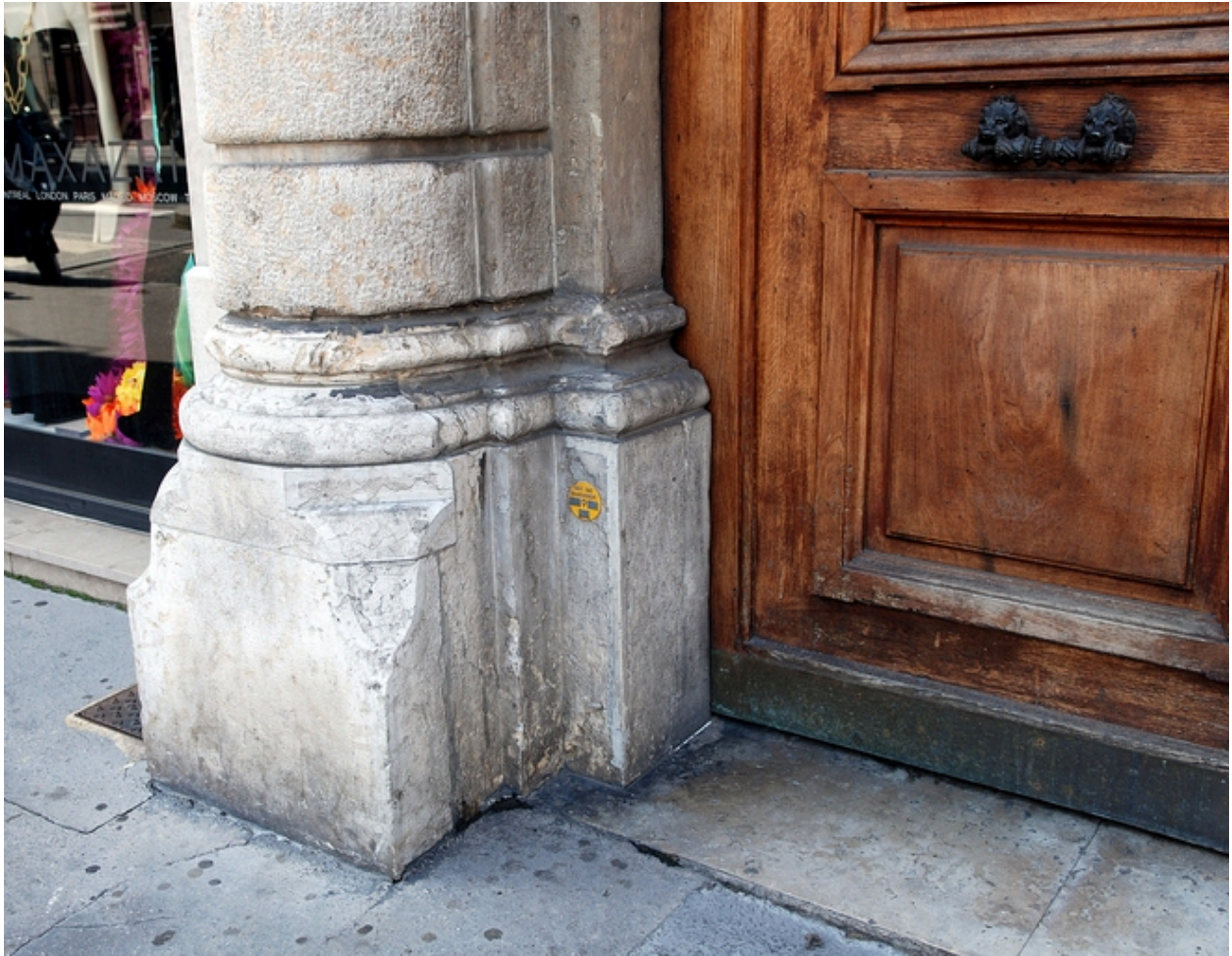
Elévation place des Jacobins : la porte, détail
