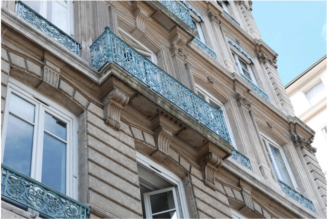
Elévation place des Jacobins : détail des balconnets
