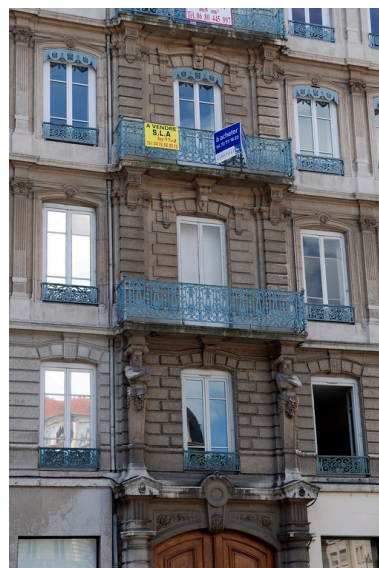
Elévation place des Jacobins : travée axiale Phot. Véronique Belle IVR82_20096904695NUCA
