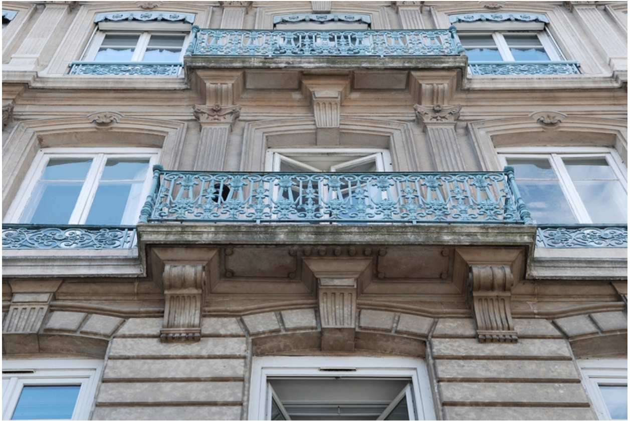
Elévation place des Jacobins : détail des balconnets
