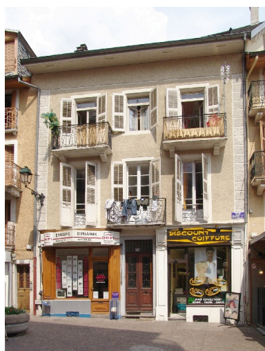
Façade Phot. François Fouger IVR82_20057300518NUCA
