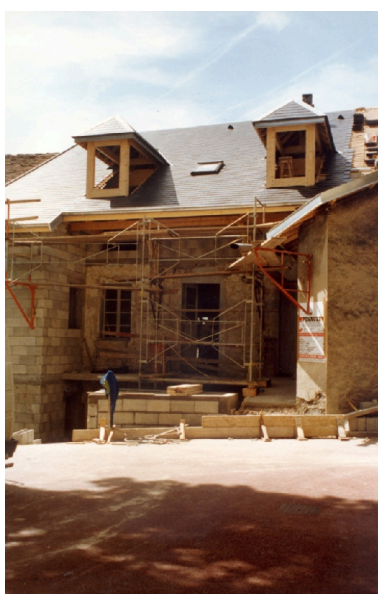
Travaux de surélévation Repro. François Fouger IVR82_20057300920NUCB
