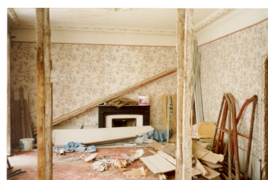
Travaux intérieurs Repro. François Fouger IVR82_20057300921NUCB
