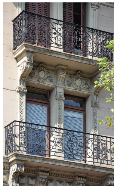
Détail des balcons des étages supérieures Phot. François Fouger IVR82_20127300278NUCA
