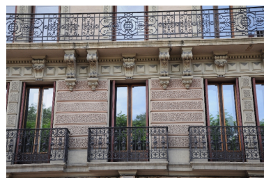
Balcons et ornements de l'étage noble Phot. François Fouger IVR82_20127300281NUCA
