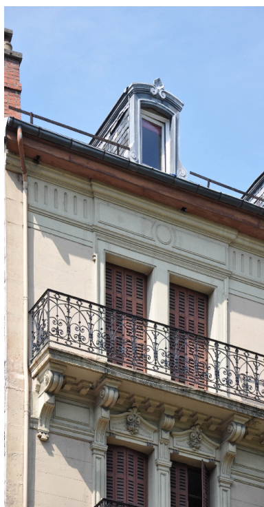
Détail d'un balcon de l'étage supérieur Phot. François Fouger IVR82_20127300279NUCA
