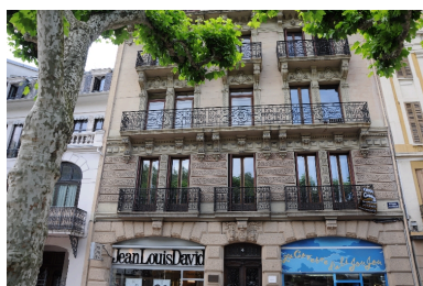
Façade principale Phot. François Fouger IVR82_20127300285NUCA
