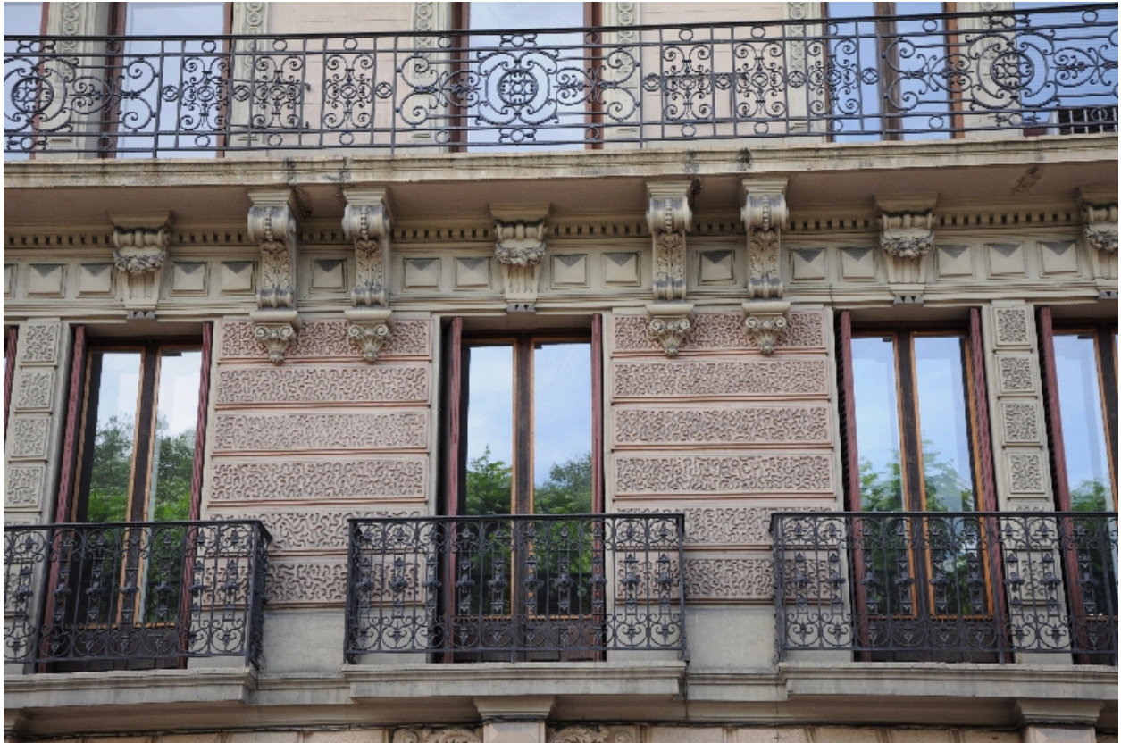
Balcons et ornements de l'étage noble
