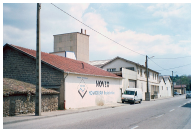
Vue générale sud-ouest Phot. Sébastien Durieu IVR82_20042600057ZA
