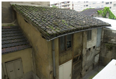
Vue des dépendances construites dans la cour, depuis l'escalier de l'immeuble Phot. François Blanchetière IVR82_20016902376NUCA
