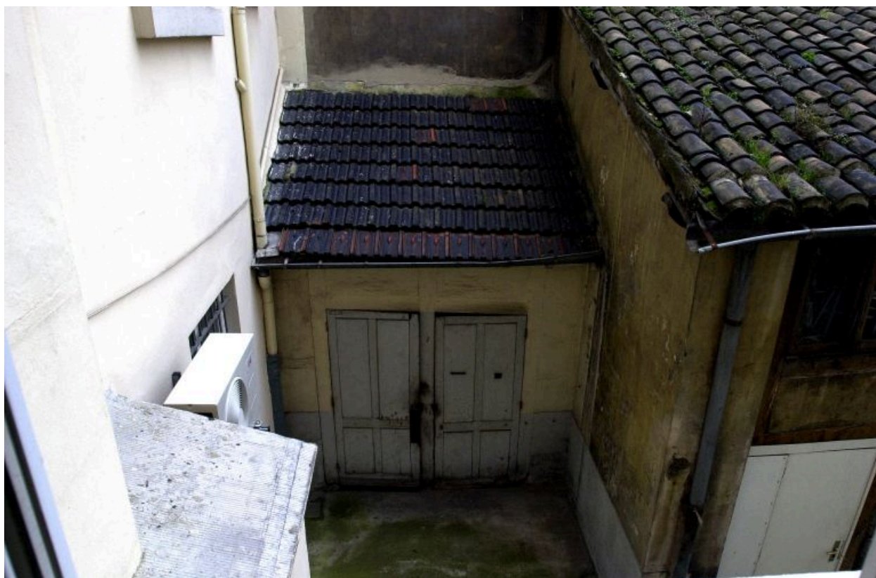
Vue des petites dépendances (WC ?) construites dans la cour, depuis l'escalier de l'immeuble
