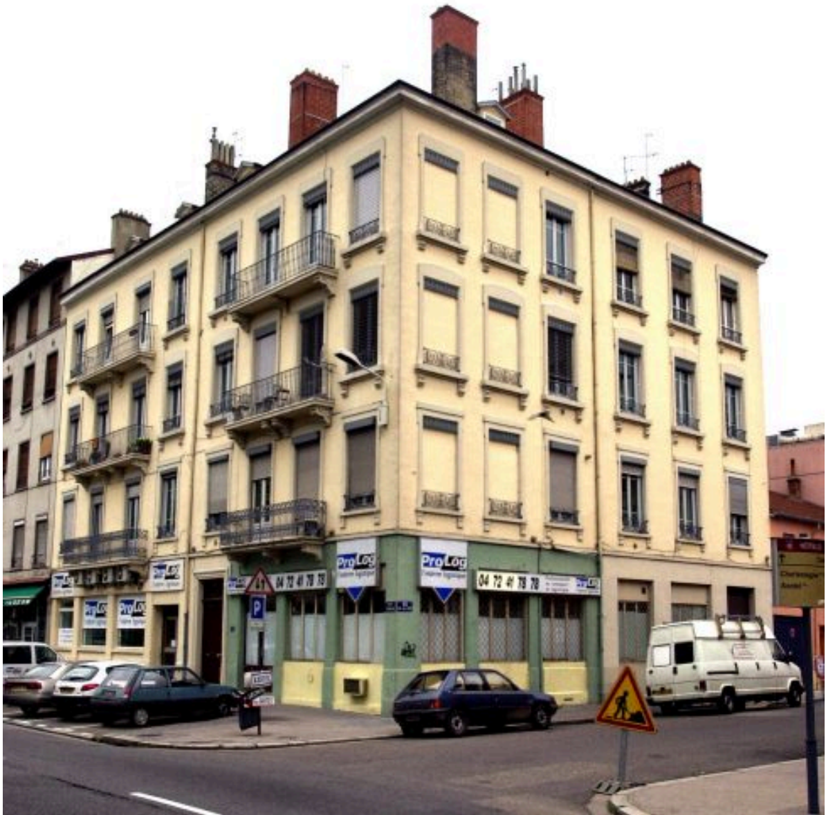
Vue d'ensemble à l'angle du quai Perrache et de la rue Marc-Antoine-Petit, depuis le nord-est
