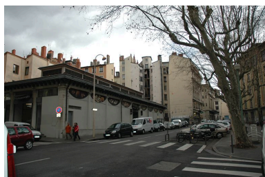
Vue partielle au niveau de la halle de la Martinière Phot. Véronique Belle IVR82_20066901124NUCA
