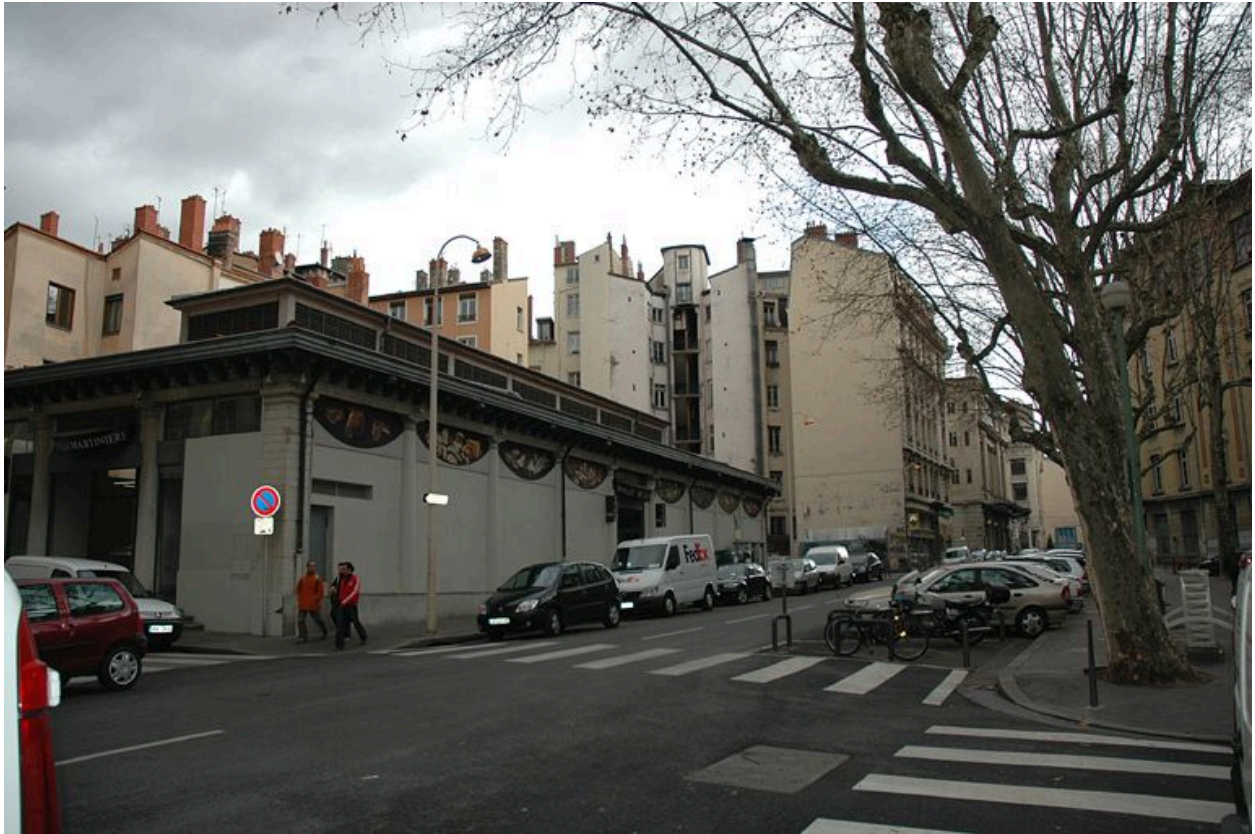
Vue partielle au niveau de la halle de la Martinière
