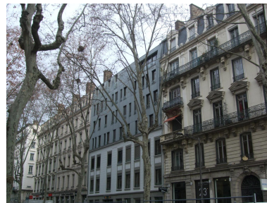
Vue d'ensemble de la société Vachon avec un rehaussement en logement Phot. Nadine Halitim-Dubois IVR84_20246900660NUCA
