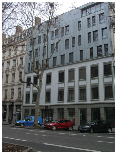
Vue d'ensemble de la société Vachon avec un rehaussement en logement Phot. Nadine Halitim-Dubois IVR84_20246900661NUCA
