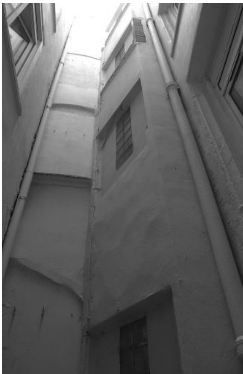
Cour ouest, tour d'escalier et galeries murées, partie médiane
