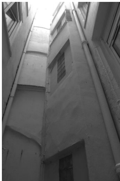
Cour ouest, tour d'escalier et galeries murées, partie médiane
