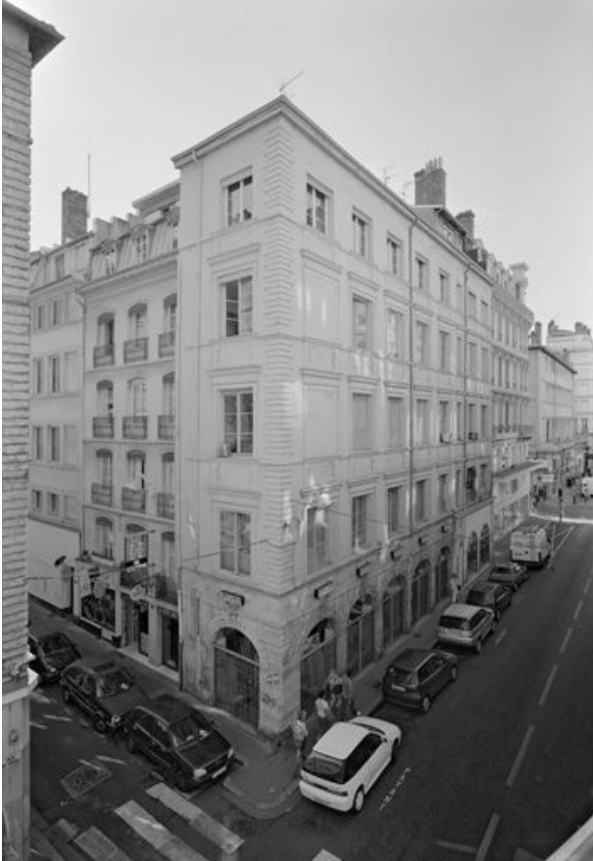
Façade, vue générale (à gauche)
