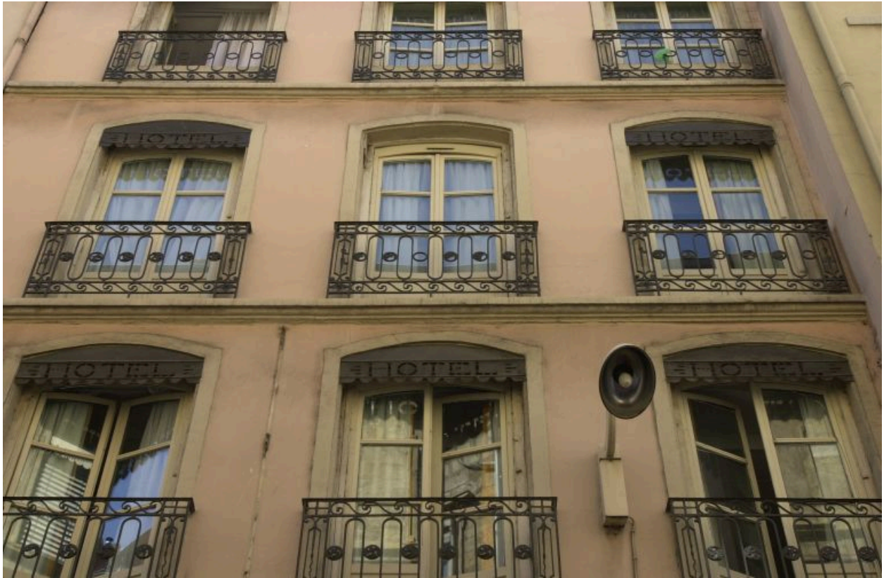
Façade, vue des fenêtres du troisième niveau
