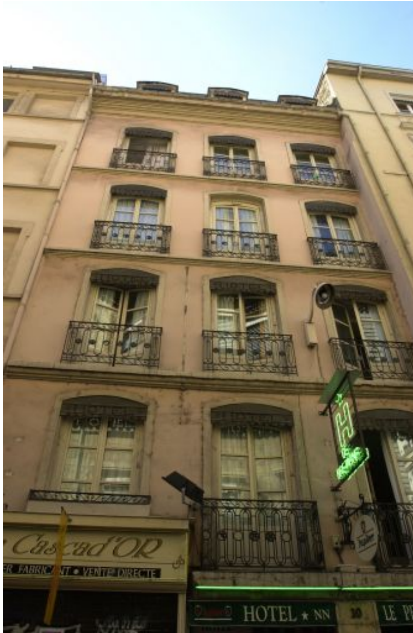
Façade, vue générale par-dessous
