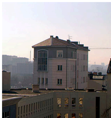
Elévations latérale nord et postérieure, depuis le nord Phot. Maryannick Chalabi
