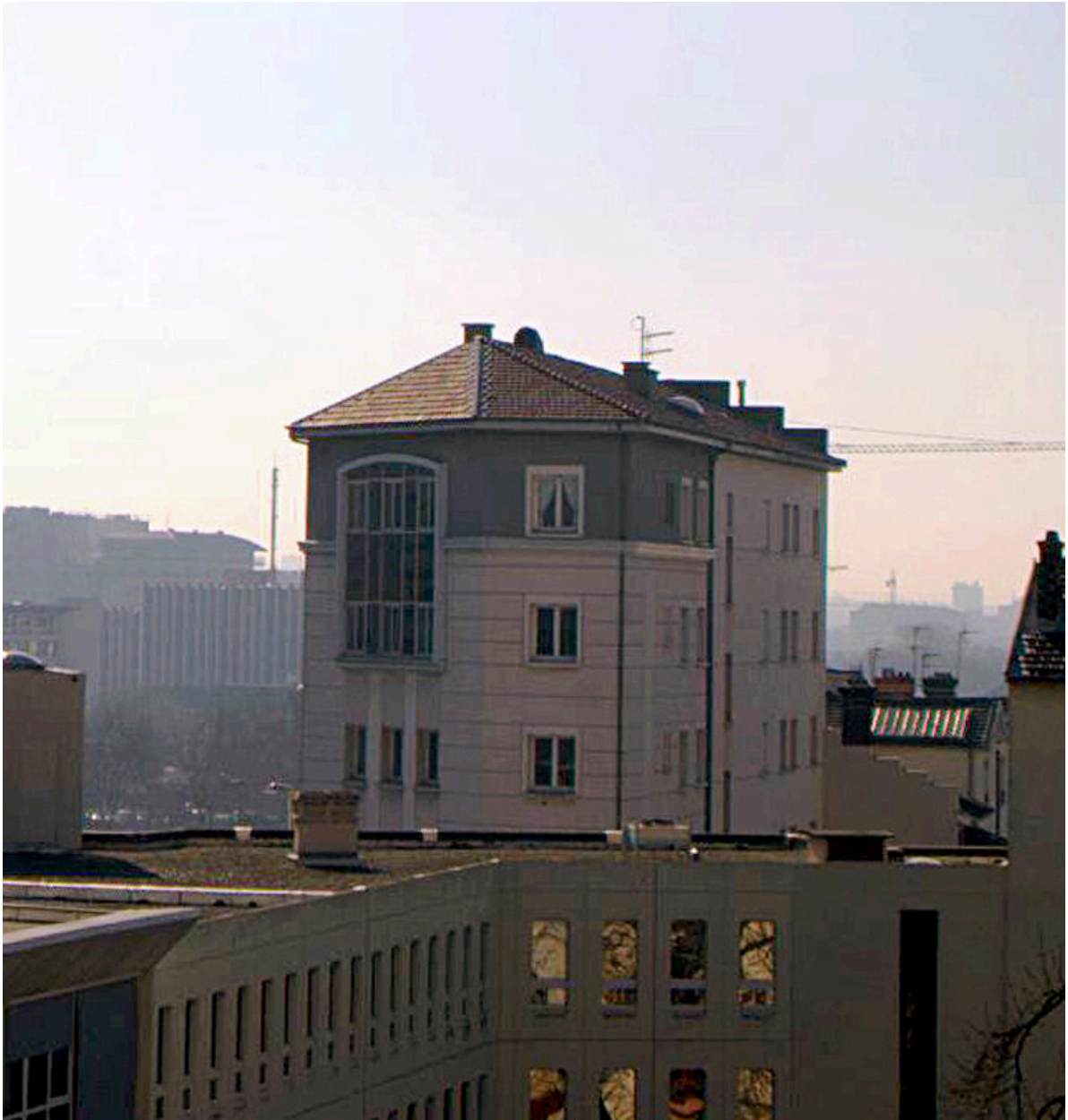
Elévations latérale nord et postérieure, depuis le nord
