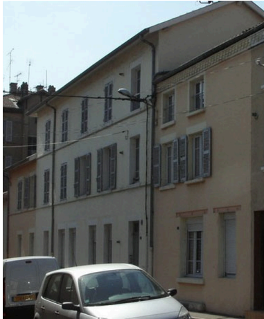
façade sud est Phot. Benoît Chapelle IVR82_20073800068NUCA
