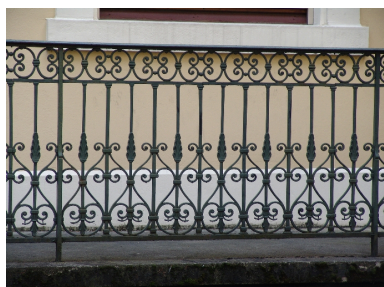
Garde-corps d'une passerelle Phot. François Fouger IVR82_20057300788NUCA
