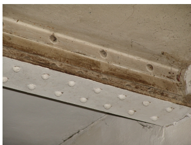
Détail d'une poutrelle métallique Phot. François Fouger IVR82_20057300789NUCA
