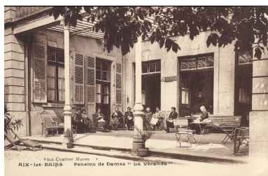
Pension de Dames : la véranda Repro. François Fouger IVR82_20047300222NUCB
