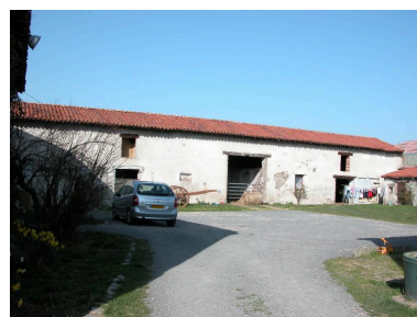
Vue d'ensemble de la grange-étable. Phot. Thierry Monnet IVR82_20144200331NUCA
