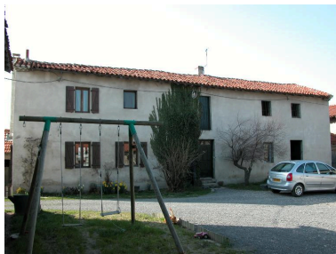
Vue d'ensemble du logis. Phot. Thierry Monnet IVR82_20144200327NUCA
