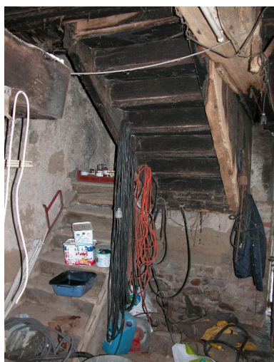
Fournil : vue d'ensemble de l'escalier. Phot. Thierry Monnet IVR82_20144200329NUCA
