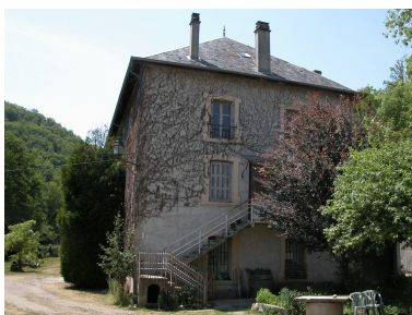
Vue du mur pignon ouest. Phot. Caroline Guibaud IVR82_20144200259NUCA
