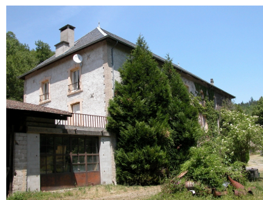
Vue d'ensemble depuis le sud-ouest. Phot. Caroline Guibaud IVR82_20144200258NUCA
