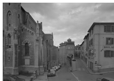
Elévation latérale droite. Phot. Eric Dessert, Phot. Jean-Marie Refflé IVR82_19910100476P
