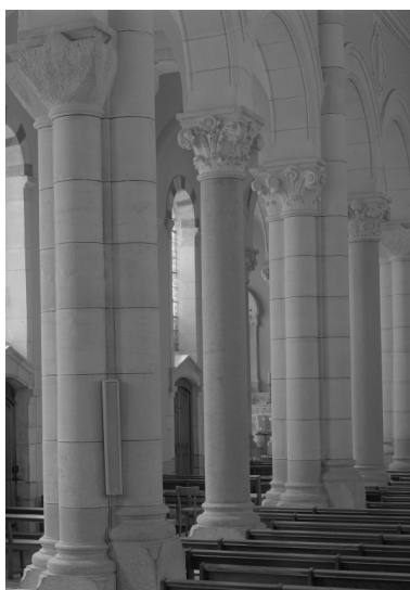
Vue partielle des piliers. Phot. Eric Dessert IVR82_19870100219P
