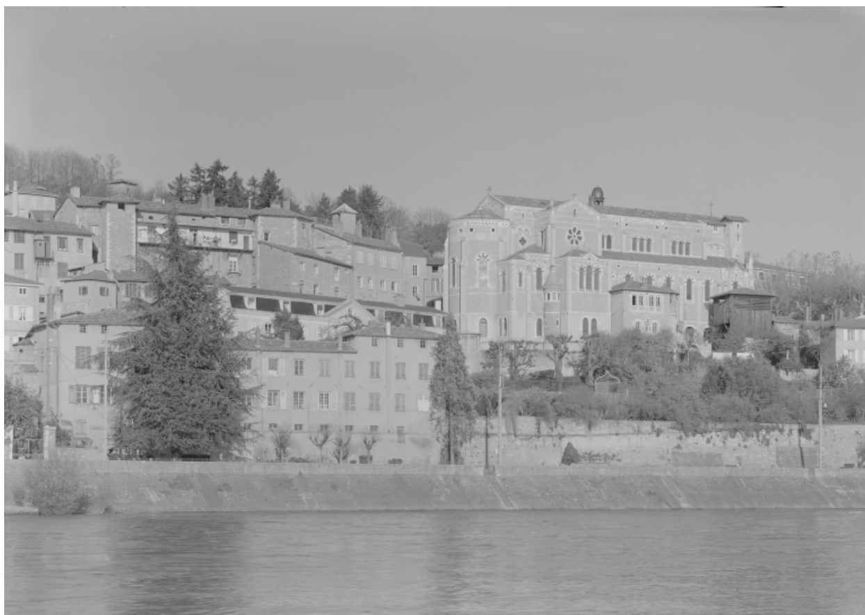
Vue du sud-ouest.
