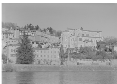
Vue du sud-ouest. Phot. Eric Dessert IVR82_19870100613P
