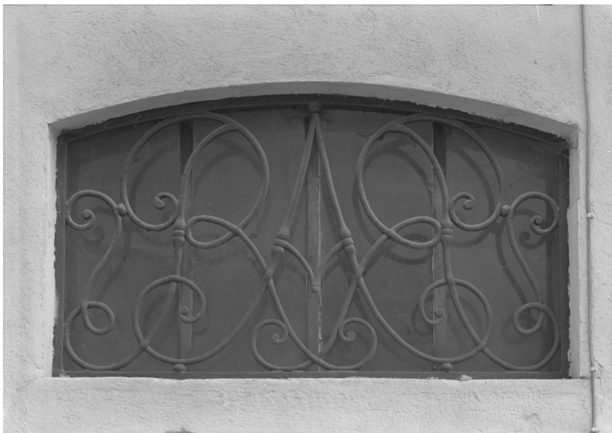
Détail de la façade principale.
