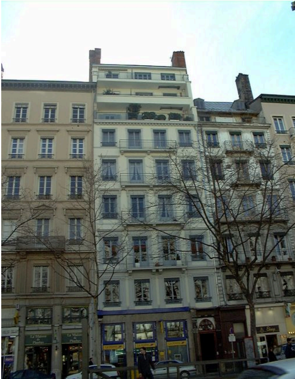
Façade sur rue, vue générale
