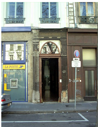
Façade sur rue, détail de la porte Phot. Bernard Ducouret IVR82_20016900833NUCA
