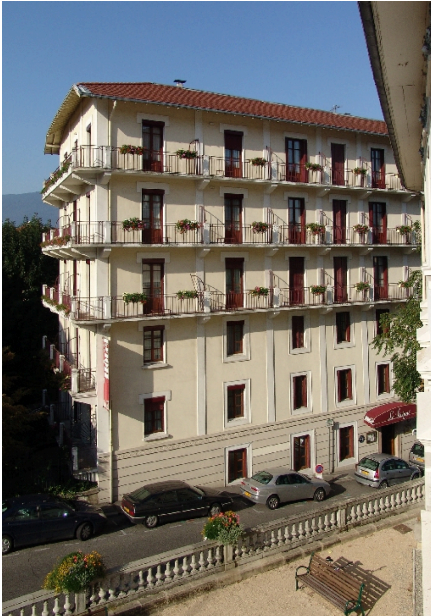
Façade sur la rue Lamartine
