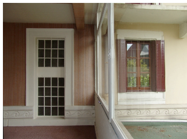
Liaison des deux ailes au premier étage Phot. François Fouger IVR82_20047300532NUCA
