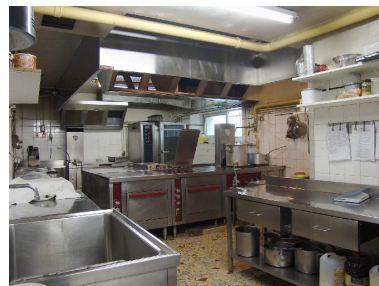
Vue générale des cuisines Phot. François Fouger IVR82_20047300531NUCA
