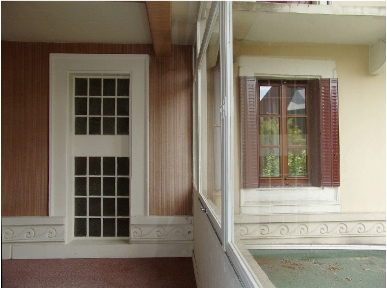
Liaison des deux ailes au premier étage
