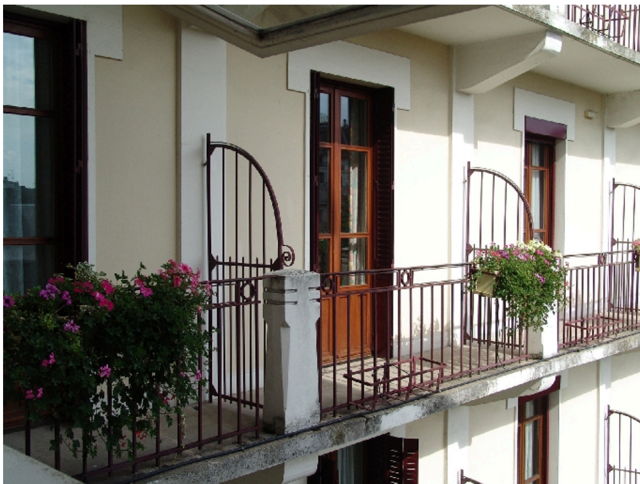
Détail des balcons
