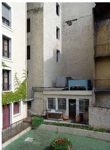
Jonction des deux ailes Phot. François Fouger IVR82_20047300528NUCA
