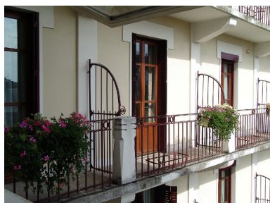
Détail des balcons Phot. François Fouger IVR82_20047300534NUCA
