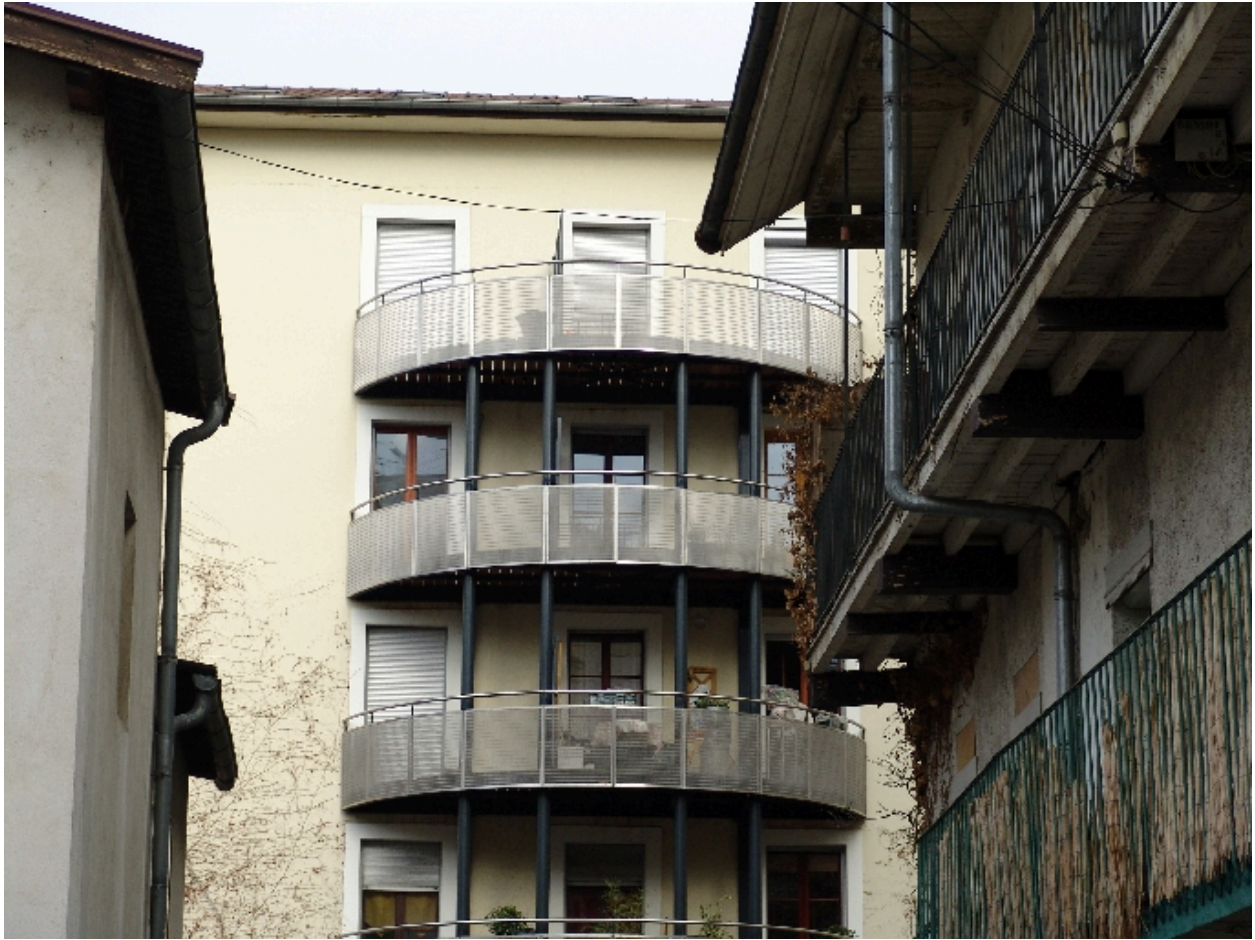
Nouveaux balcons postérieurs
