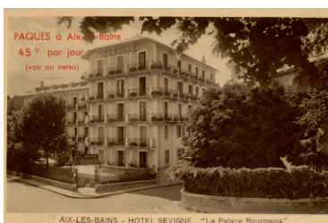
Vue générale Repr. François Fouger IVR82_20047300519NUCB
