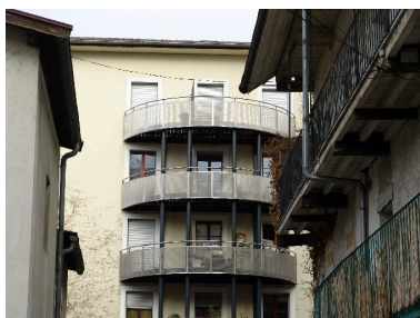
Nouveaux balcons postérieurs Phot. François Fouger IVR82_20097300067NUCA
