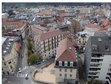
Vue cavalière Phot. François Fouger IVR82_20057300499NUCA
