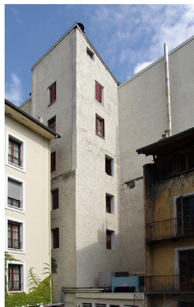
Angle sur cour des deux ailes Phot. François Fouger IVR82_20047300529NUCA
