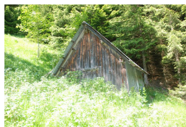
Abri à la Cochette, non cadastré, vers 2013 C4 398. Phot. Thierry Monnet IVR84_20167302395NUCA
