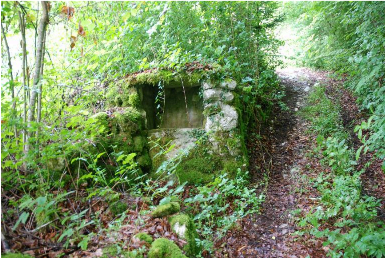
Chemin d'accès vers un petit bâtiment non repéré dans la forêt de Prépoulain (non cadastré, vers 2013 C1 1 ou 2) : puits.
