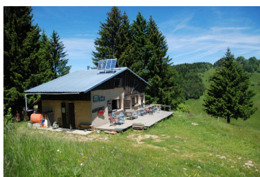
Le refuge du Creux de Lachat (non repéré). Phot. Thierry Monnet IVR84_20167302393NUCA
