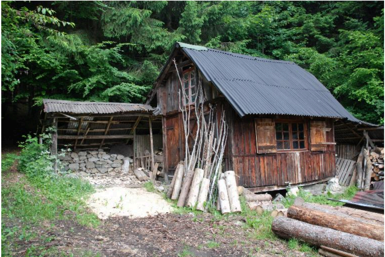
Vue d'un petit bâtiment non repéré dans la forêt de Prépoulain (non cadastré, vers 2013 C1 1 ou 2).
