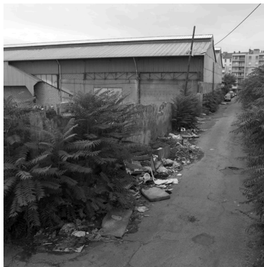
Vue est de l'impasse de l'Asphalte Phot. Didier Gourbin IVR82_20056900038NUC
