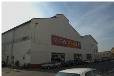
Vue nord-ouest Phot. Nadine Halitim-Dubois IVR82_20086900398NUCA
