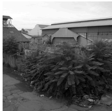
Vue sud-est Phot. Didier Gourbin IVR82_20056900039NUC
