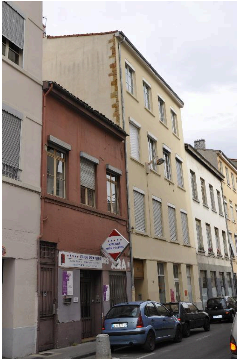
Vue d'ensemble sud est de l'immeuble de trois étages
