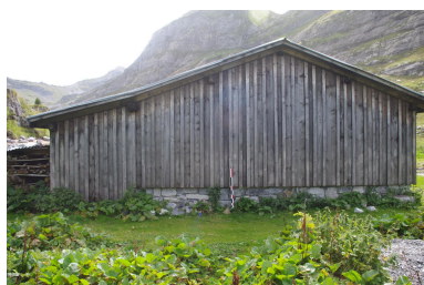
Vue du mur pignon nord Phot. Samir Mahfoudi IVR84_20227402239NUCA
