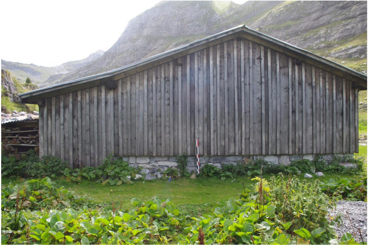
Vue du mur pignon nord
