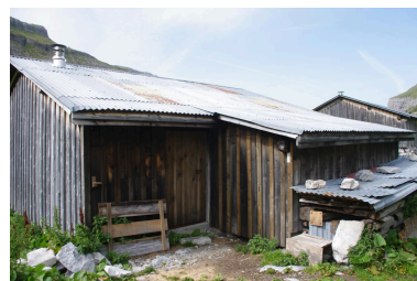
Vue de l'extension en appentis adossée à la façade postérieure est Phot. Samir Mahfoudi IVR84_20227402238NUCA
