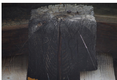
Détail de la panne faîtière avec l'inscription « PG 1889 » Phot. Samir Mahfoudi IVR84_20227402240NUCA
