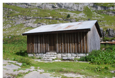
Vue d'ensemble Phot. Samir Mahfoudi IVR84_20227402241NUCA
