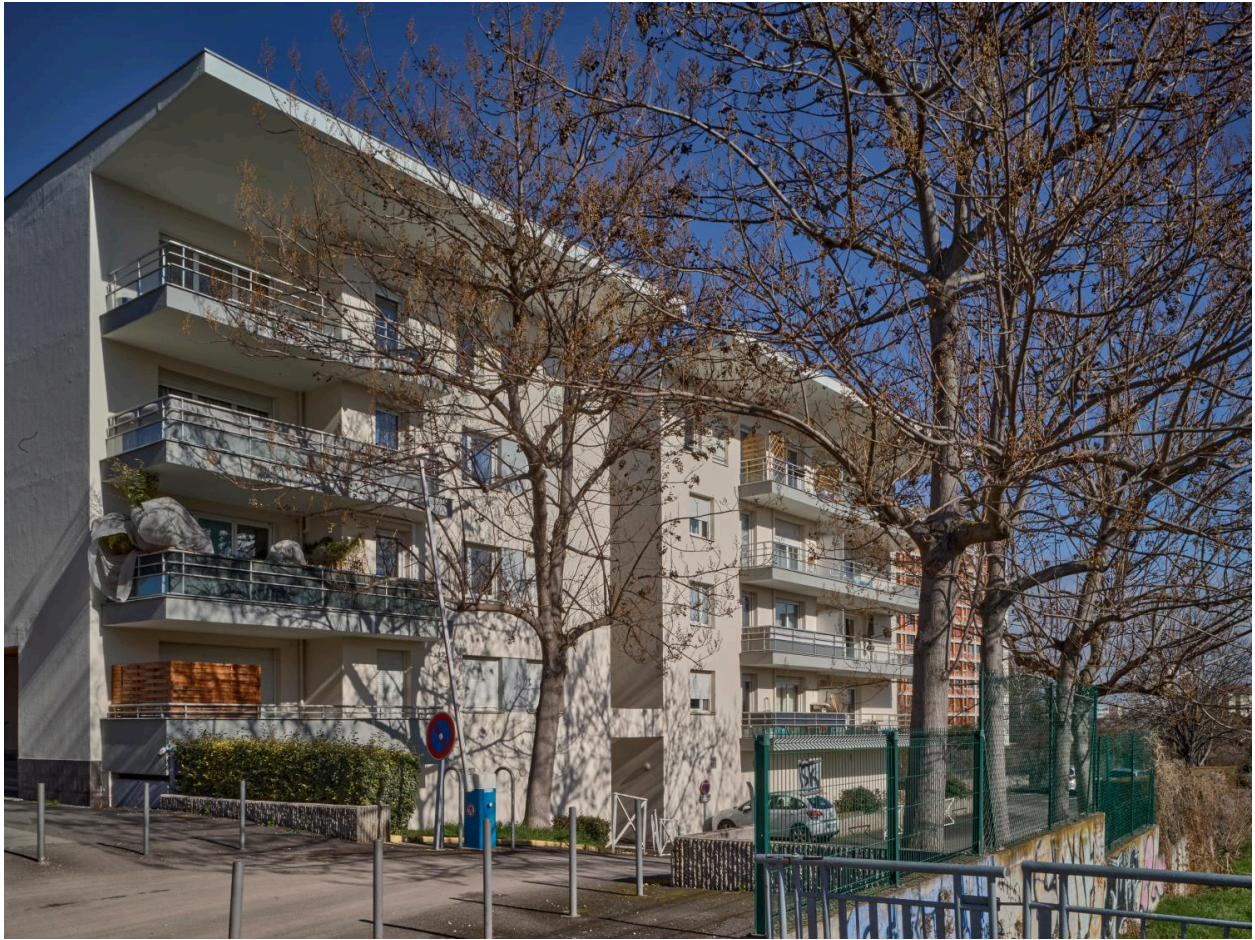
Elévation postérieure donnant sur la tranchée de chemin de fer
