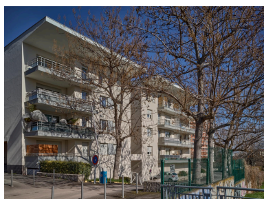
Elévation postérieur donnant sur la tranchée de chemin de fer Phot. Christian Parisey IVR84_20246300381NUC4A
