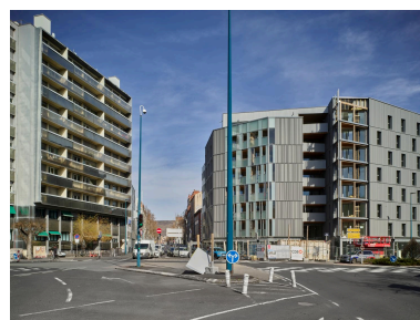
Débouché de l'avenue d'Italie sur le carrefour de l'avenue de l'Union soviétique et de Grande - Bretagne (dit "place de l'Esplanade") Phot. Christian Parisey IVR84_20236300286NUC4A
