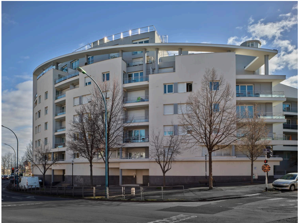
Façade au carrefour de l'avenue des Paulines et de la rue de l'Oradou
