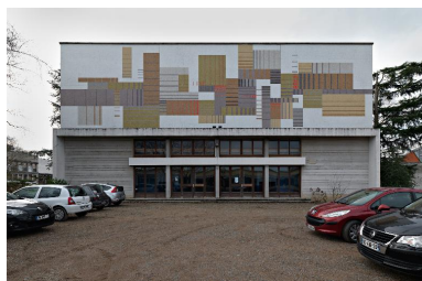
Elévation principale Phot. Eric Dessert IVR84_20174200004NUCA
