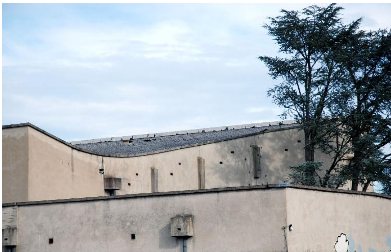
Détail du toit
