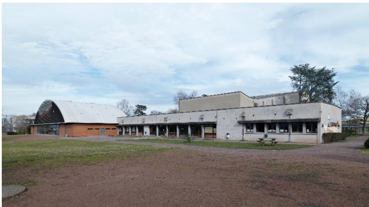
Vue d'ensemble depuis le sud-est ; à gauche le gymnase
