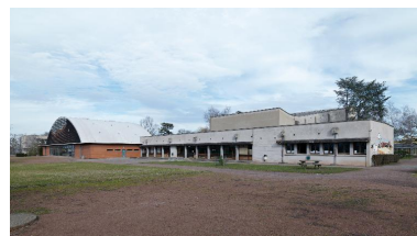
Vue d'ensemble depuis le sud-est ; à gauche le gymnase
