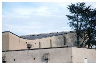
Détail du toit Phot. Catherine Guégan IVR84_20174200119NUCA
