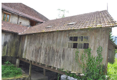
Mur goutterau nord de la halle de la scierie Phot. Samir Mahfoudi, Autr. Samir Mahfoudi IVR82_20117401163NUCA
