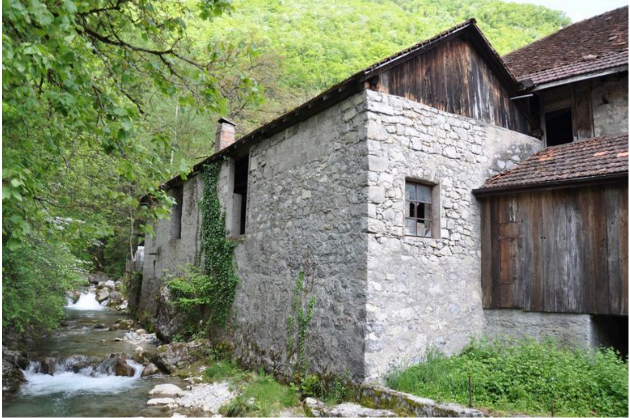
Elévation sud-est du bâtiment du battoir
