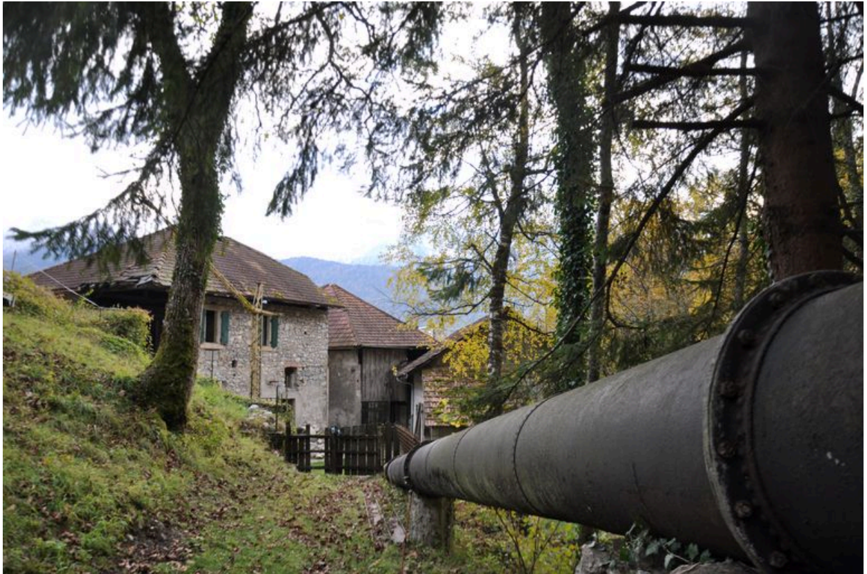
Conduite forcée attaquant la turbine de la scierie Demaison
