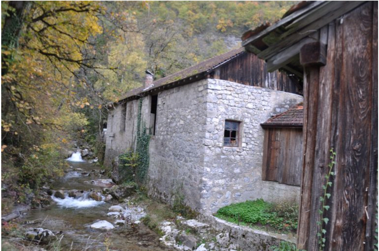
Façade latérale de la scierie Demaison donnant sur le ruisseau de Montmin
