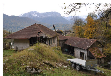
Vue d'ensemble de la scierie prise depuis le jardin Phot. Samir Mahfoudi, Autr. Samir Mahfoudi IVR82_20117401469NUCA
