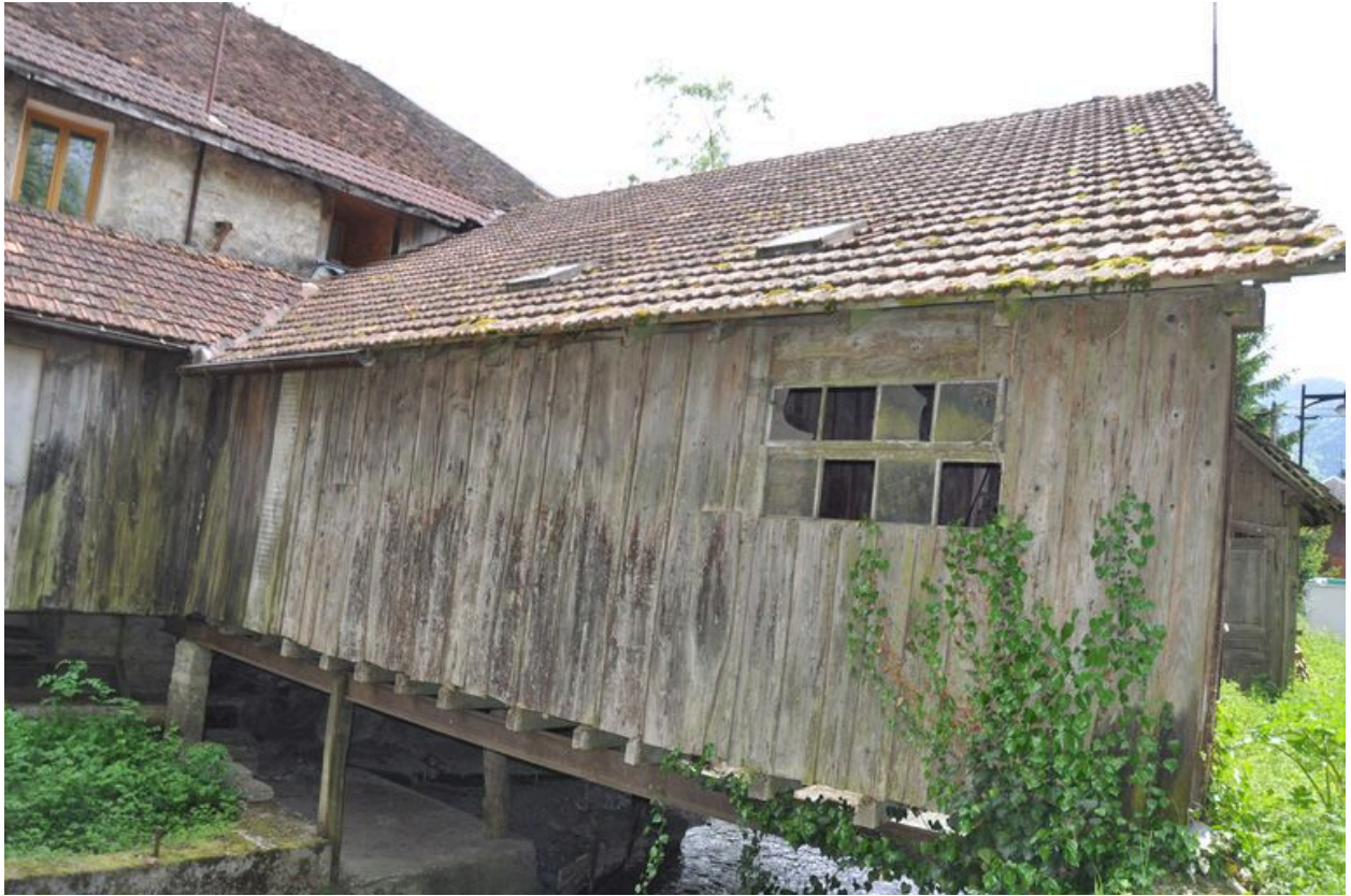
Mur goutterau nord de la halle de la scierie
