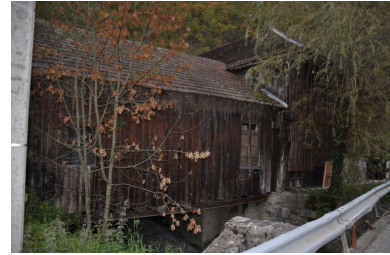
Vue de la halle enjambant le ruisseau de Montmin prise depuis le pont de Vesonne Phot. Samir Mahfoudi, Autr. Samir Mahfoudi IVR82_20117401472NUCA
