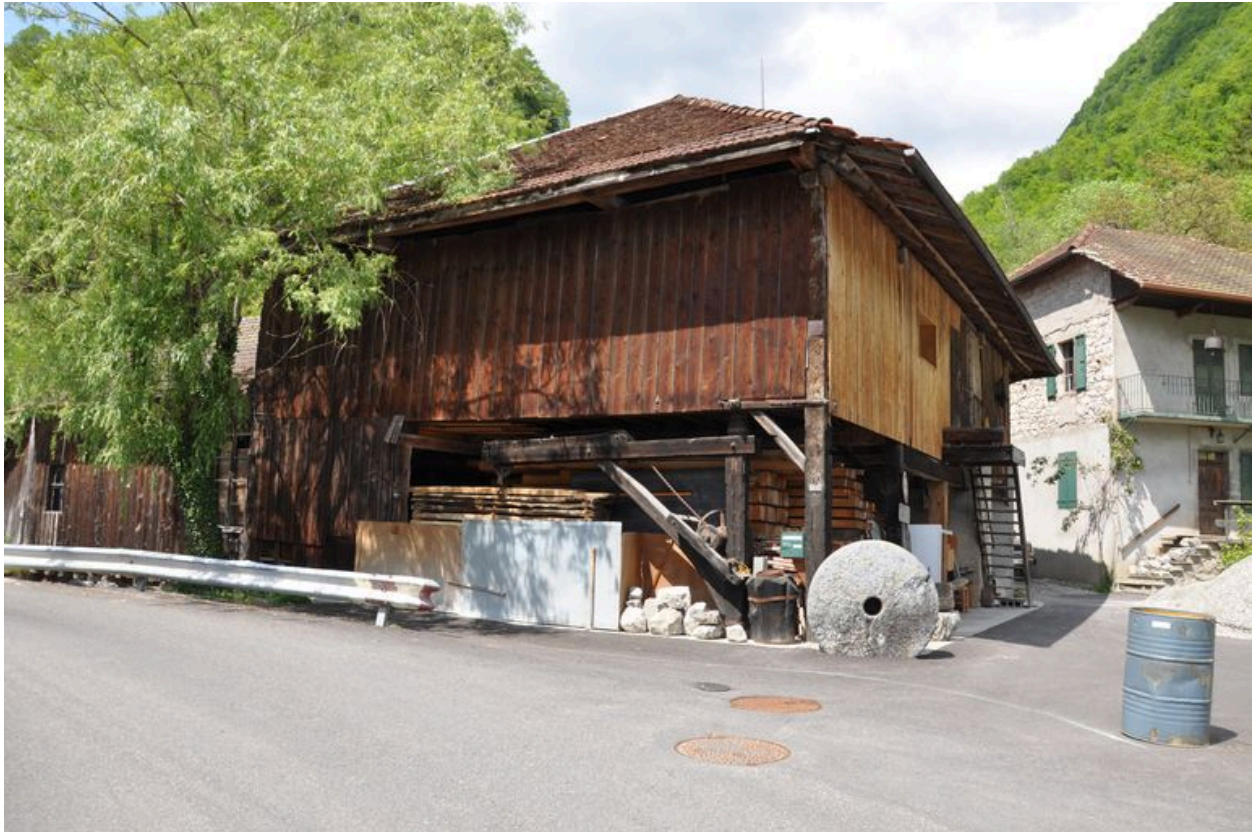
Mur pignon sud de la halle de la scierie
