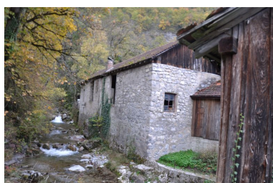
Façade latérale de la scierie Demaison donnant sur le ruisseau de Montmin Phot. Samir Mahfoudi, Autr. Samir Mahfoudi IVR82_20117401082NUCA
