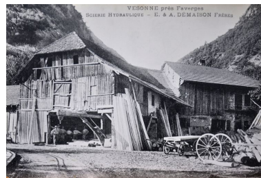
Vesonne près Faverges, scierie hydraulique, E.& A. Démaison Frères, n.p. Phot. Samir Mahfoudi, Autr. ARTO PHOT. Annecy IVR82_20117401465NUCA
