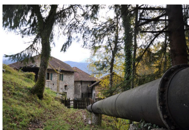
Conduite forcée attaquant la turbine de la scierie Demaison Phot. Samir Mahfoudi, Autr. Samir Mahfoudi IVR82_20117401468NUCA
