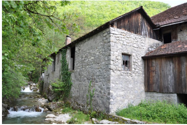
Elévation sud-est du bâtiment du battoir Phot. Samir Mahfoudi, Autr. Samir Mahfoudi IVR82_20117401167NUCA
