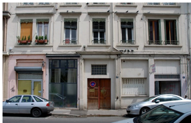
Élévation antérieure, rez-de-chaussée Phot. Catherine Guégan IVR82_20096900771NUCA
