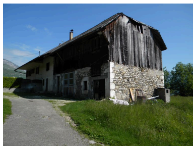
Vue des parties agricoles sur la façade principale. Phot. Jérôme Daviet IVR82_20117403587NUCA
