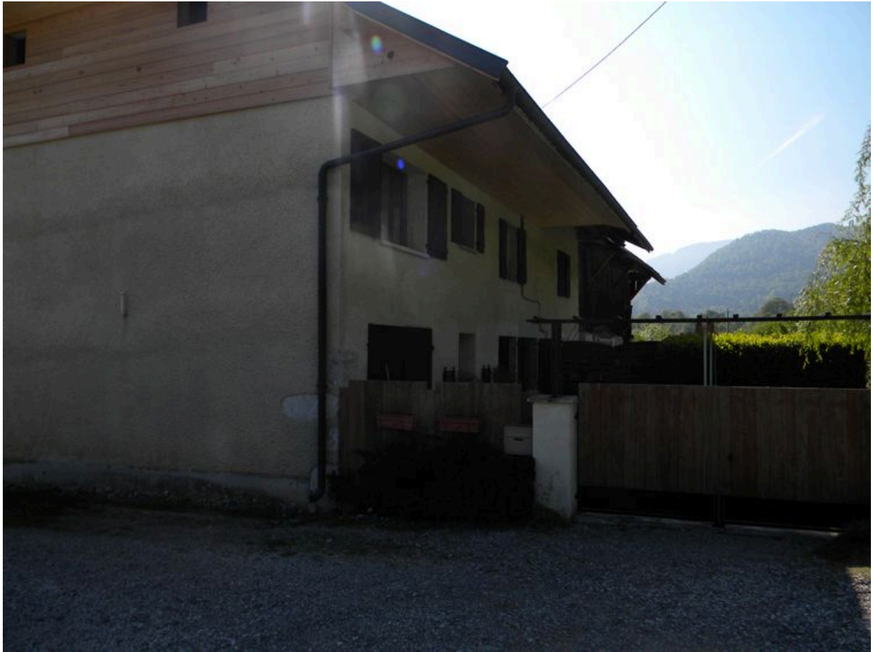
Vue de la partie habitation sur la partie nord-ouest.
