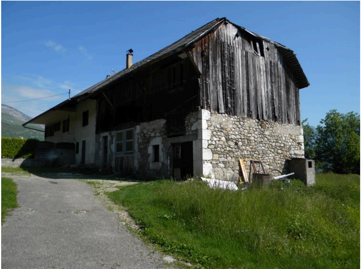
Vue des parties agricoles sur la façade principale.
