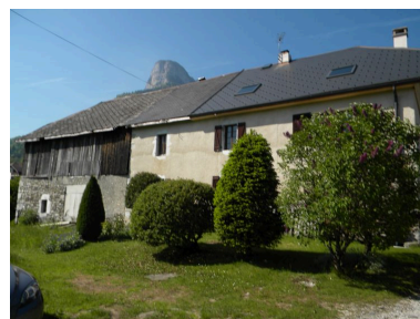
Vue de la façade arrière avec les parties habitations et agricoles. Phot. Jérôme Daviet IVR82_20117403586NUCA
