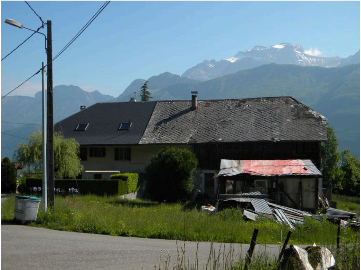
Vue générale depuis le hameau de marceau-dessus.
