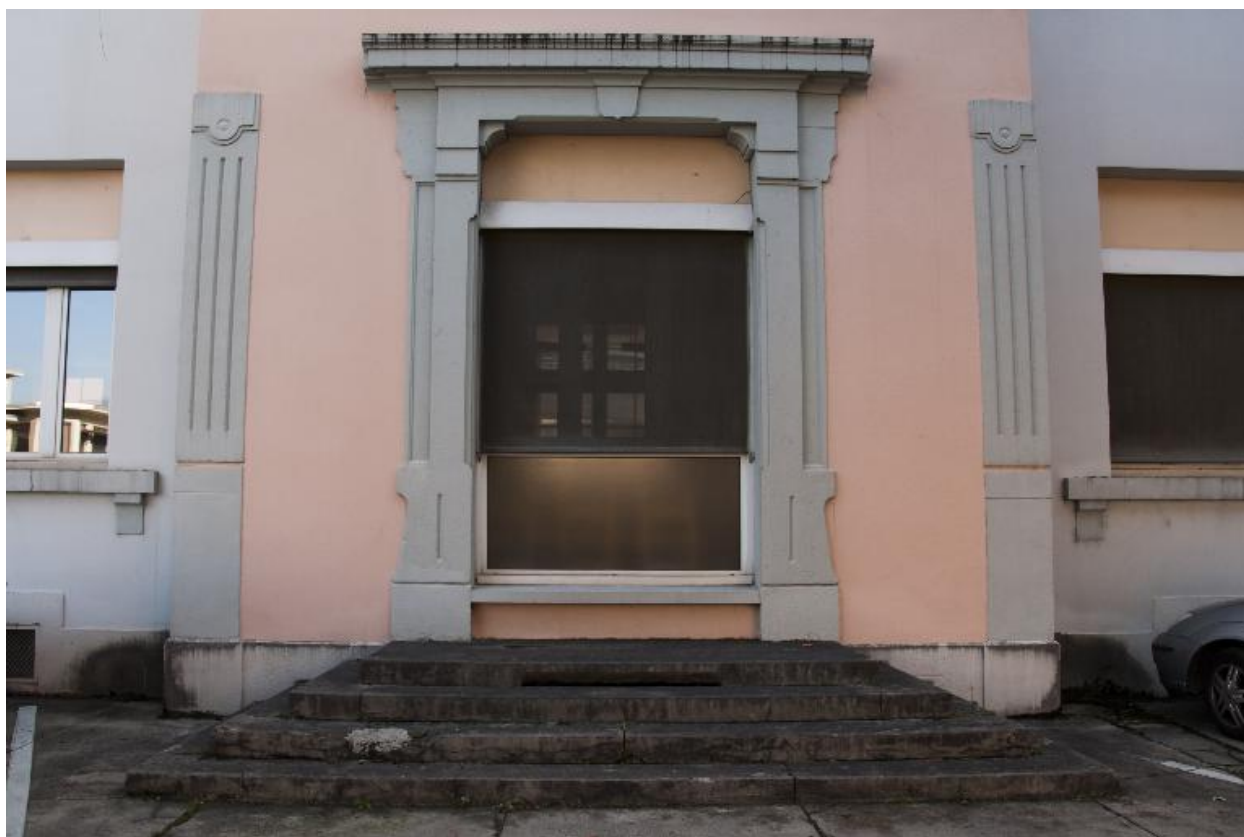
Ancienne porte d'entrée principale
