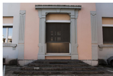
Ancienne porte d'entrée principale Phot. Denys Harreau IVR82_20157300086NUCA
