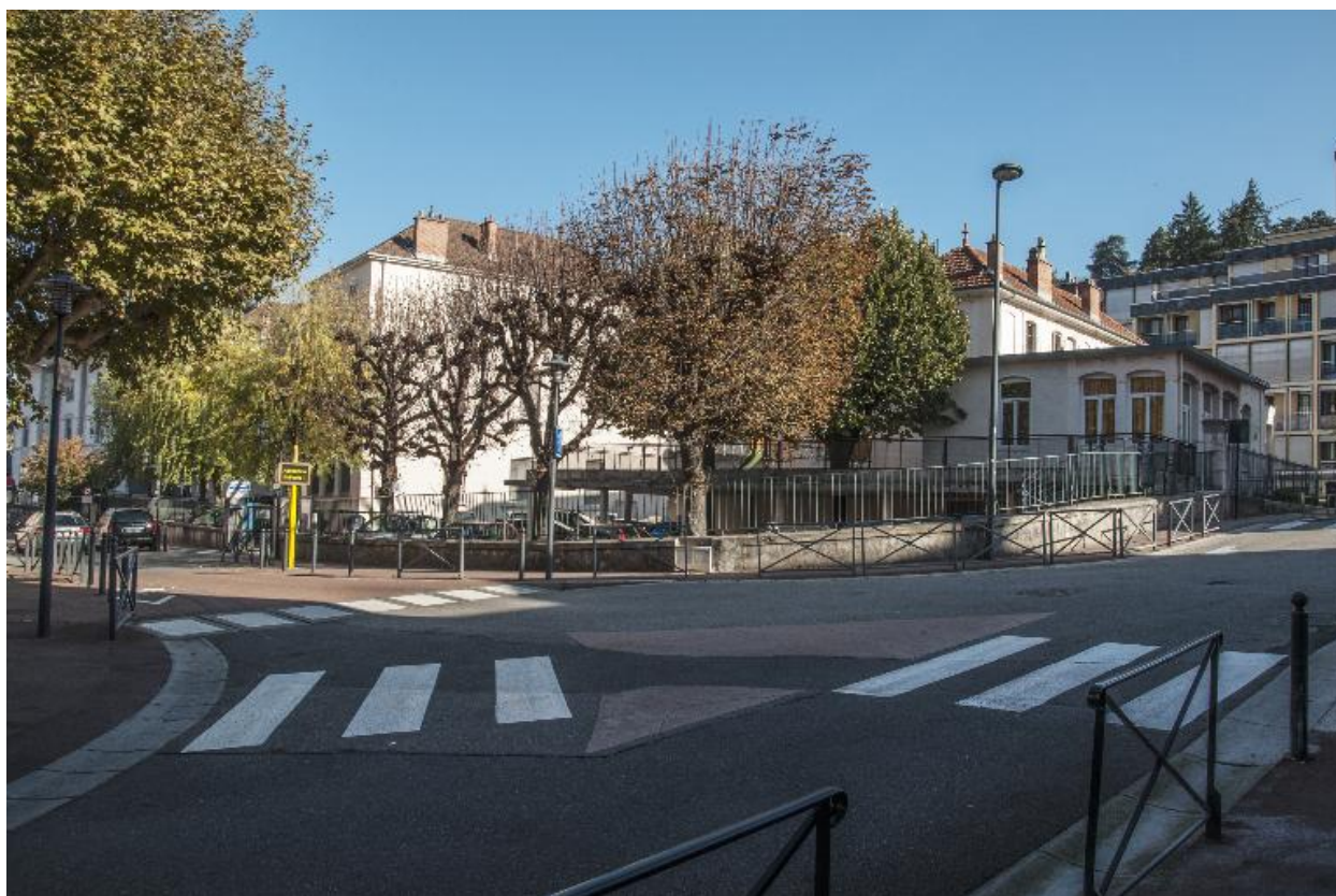
Vue d'ensemble depuis la rue
