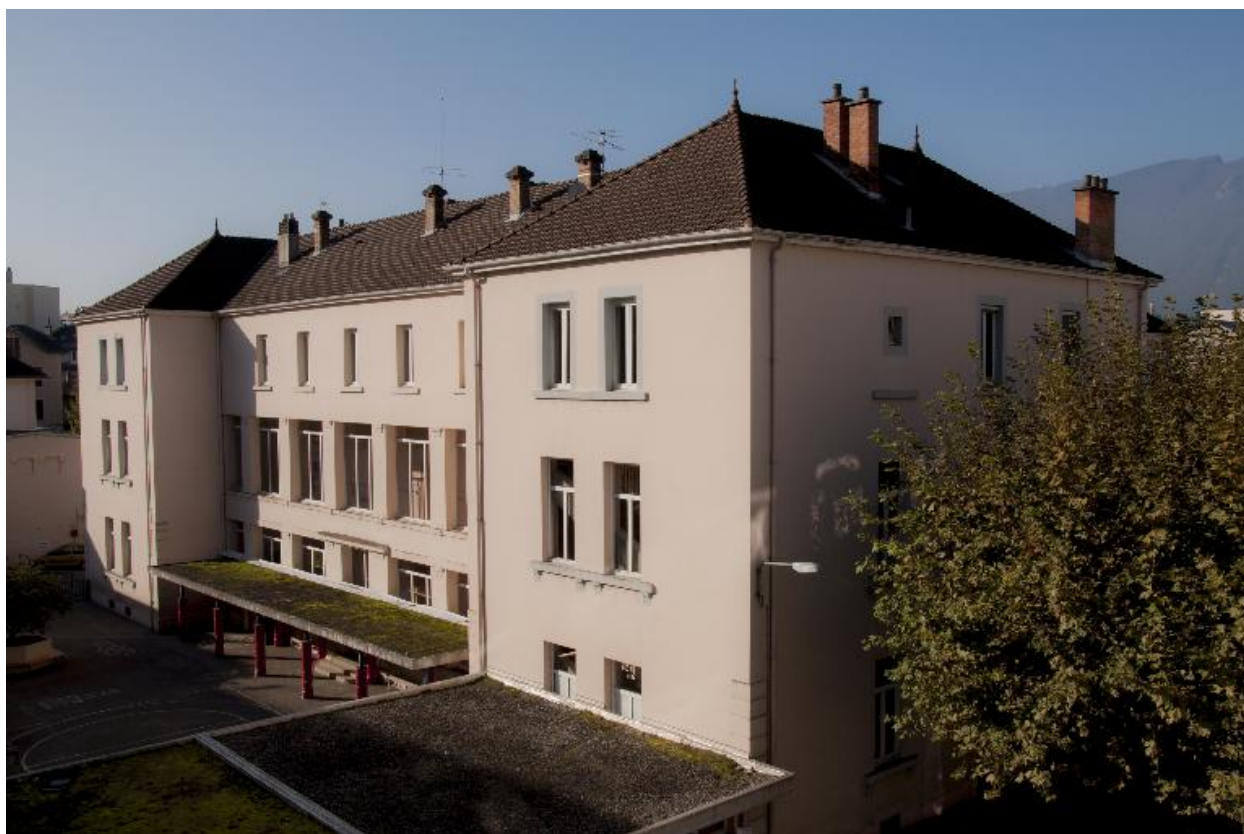
Vue d'ensemble : élévation postérieure
