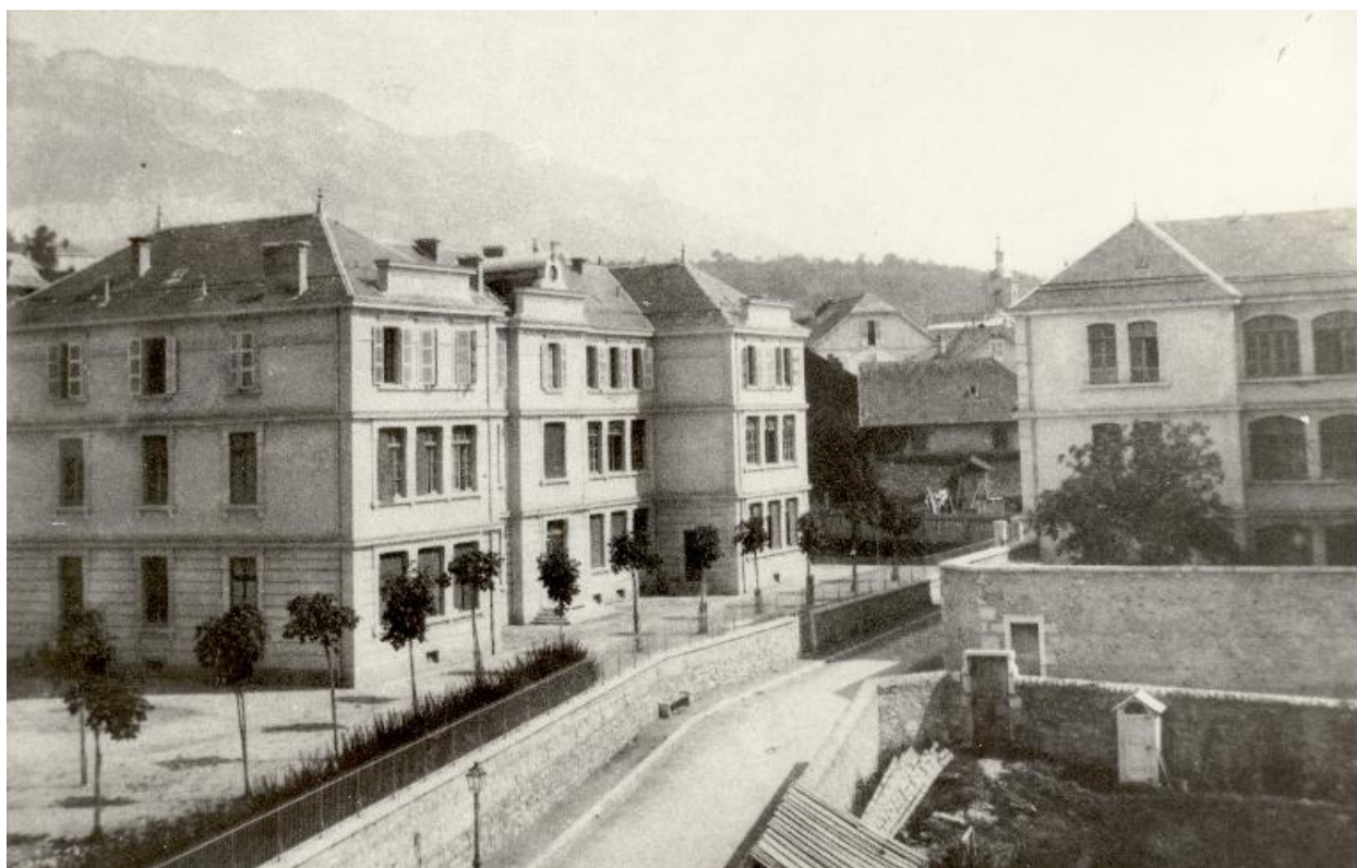
Vue depuis le nord, 1889
