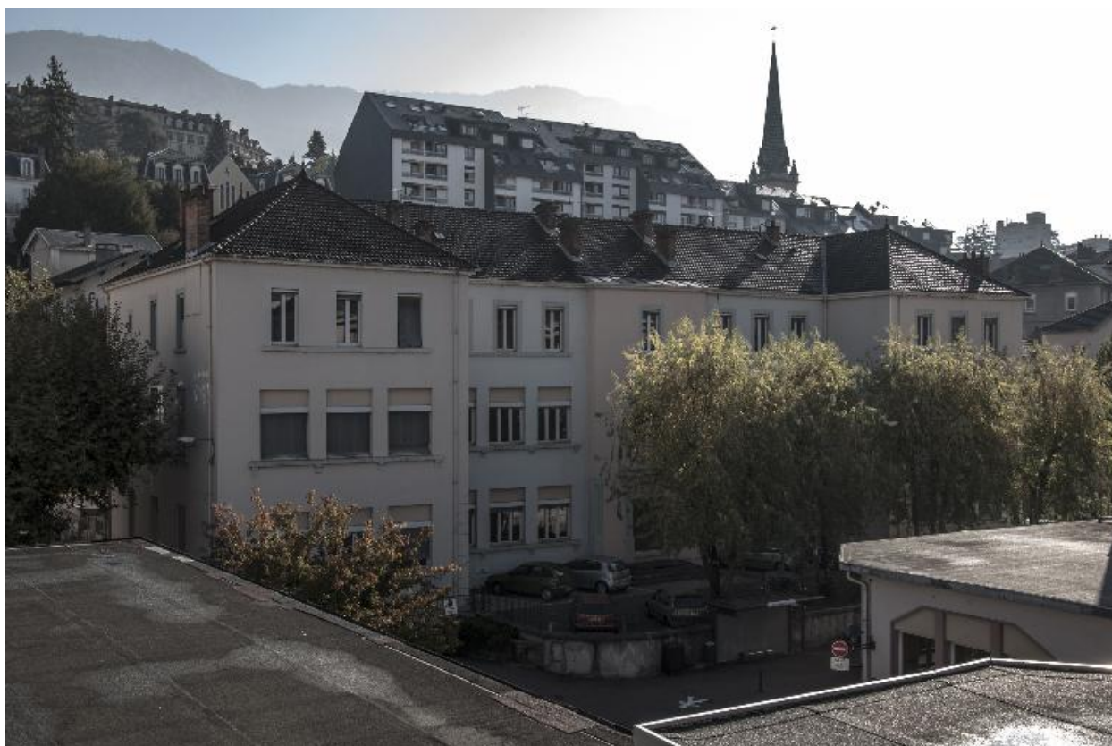
Vue d'ensemble : élévation antérieure
