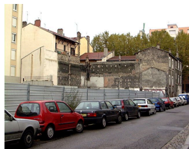
Vue d'ensemble depuis le sud. Les murs en mâchefer. Phot. Bernard Ducouret IVR82_20006900540NUCA
