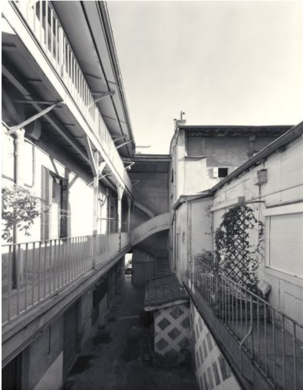
Vue d'ensemble de la cour et des dessertes depuis l'ouest
