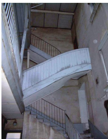
Vue d'ensemble de l'escalier desservant le 2 et le 4 rue Seguin Phot. Bernard Ducouret IVR82_20006900538NUCA
