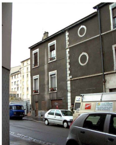
Vue générale depuis le cours Suchet Phot. Bernard Ducouret IVR82_20006900536NUCA
