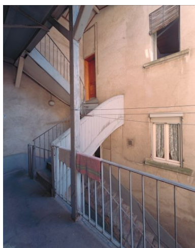
Vue d'ensemble de l'escalier desservant le 2 et le 4 rue Seguin Phot. Eric Dessert IVR82_20026903014VE
