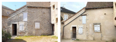
Façade est du bâtiment sur cour avant et après restauration. IVR84_20260300387NUCA
