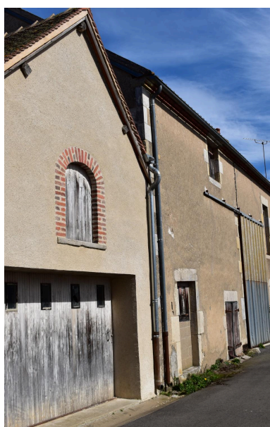
Détail du pignon du bâtiment de la parcelle 1341 sur la rue du Trou Gandou, actuellement salle d'exposition. En 2024, avant restauration de 2025. Phot. Maryse Durin-Tercelin
