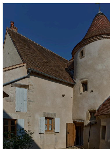
Vue de détail de l'édifice sur la cour. Phot. Christian Parisey IVR84_20240300266NUCA4A
