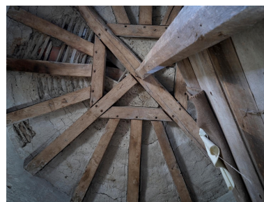
Détail de l'enrayure de la charpente conique au sommet de l'escalier. Phot. Christian Parisey IVR84_20240300267NUC4A
