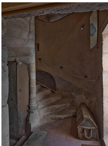
Vue de la base de l'escalier en vis. Phot. Christian Parisey IVR84_20240300262NUC4A
