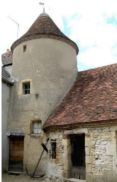
Façade méridionale du bâtiment sur cour avant restauration IVR84_20260300386NUCA
