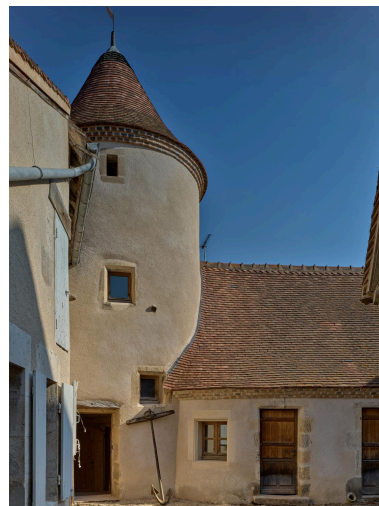
Vue de détail de la façade méridionale du bâtiment côté cour après restauration. Phot. Christian Parisey IVR84_20240300264NUC4A
