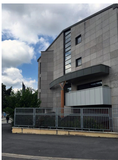
Emplacement actuel, devant l'internat. L'œuvre est peu visible en raison de la densité de la végétation Phot. Catherine Guégan IVR84_20200100690NUCA
