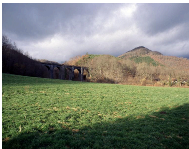
Site du viaduc ferroviaire de Bassignac. A l'arrière-plan, le puy de Frousty. Phot. Isabelle Védrine IVR83_19951500356XA
