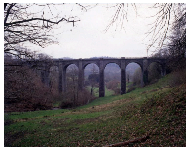
Viaduc ferroviaire de Bassignac. Aucun guide ne mentionne ce viaduc, délaissé au profit d'un autre ouvrage d'art plus important sur la Sumène, à quelques kilomètres de là (voir illustrations dans ce dossier). Phot. Isabelle Védrine IVR83_19951500954XA
