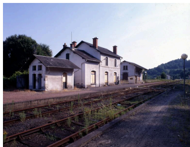
La gare dite de Champagnac à Ydes-l'Hôpital, côté voies. Champagnac est désignée par les guides de toutes les époques (jusque dans les années 1950, l'exploitation de la mine ayant cessé en 1959) comme Champagnac-les-Mines, le hameau de l'Hôpital étant au centre du bassin houiller de Champagnac. Phot. Isabelle Védrine IVR83_19951502311XA
