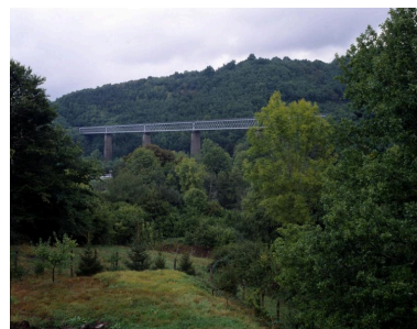
Un des ouvrages d'art de la ligne : le viaduc de la Sumène, sur la commune de Bassignac. Phot. Roger Choplain, Phot. Roland Maston IVR83_19921500302XA
