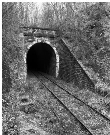
Tunnel de Prensol depuis la voie ferrée. Jusque dans les années 1920, les guides mentionnent systématiquement (souvent avec leurs longueurs respectives) les deux grands tunnels franchis par la ligne de chemin de fer à proximité de Vendes. Celui de Prensol, avec 534 m, est le plus long de deux. Phot. Isabelle Védrine IVR83_19951500701X
